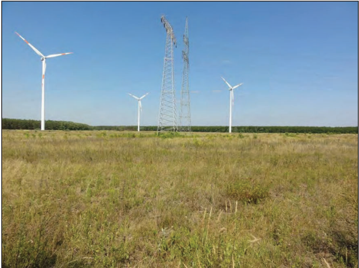
Abbildung 83:Foto südlich Maststandort 92 Bestandstrasse in nördlicher Richtung (Foto 23.08.2019)
