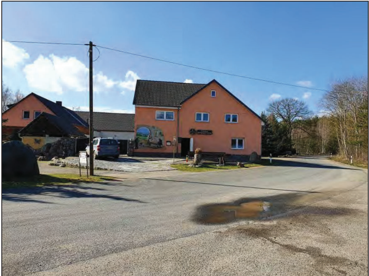
Abbildung 85: Betroffener Siedlungsbereich in Göritz, Greifenhainer Straße, Gaststätte und Pension „Drehpunkt Göritz“ (Foto 05.03.2020)
