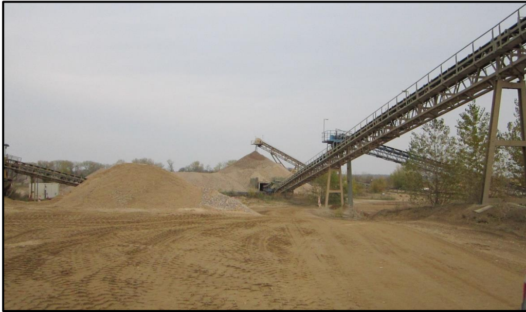
Abbildung 10: Rohkiesfreilager mit Unterflurabzug
