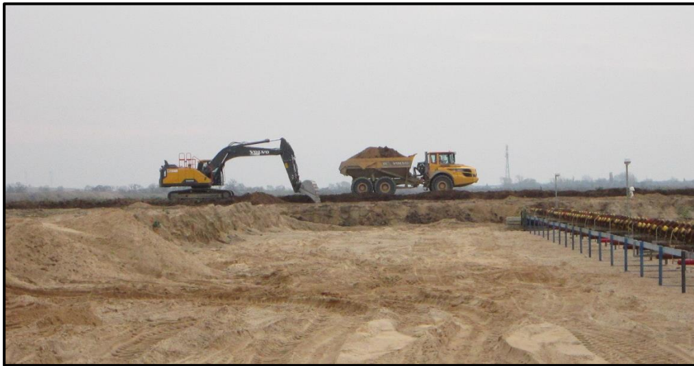
Abbildung 7: Abraumräumung mittels Hydraulikbagger und Dumper
