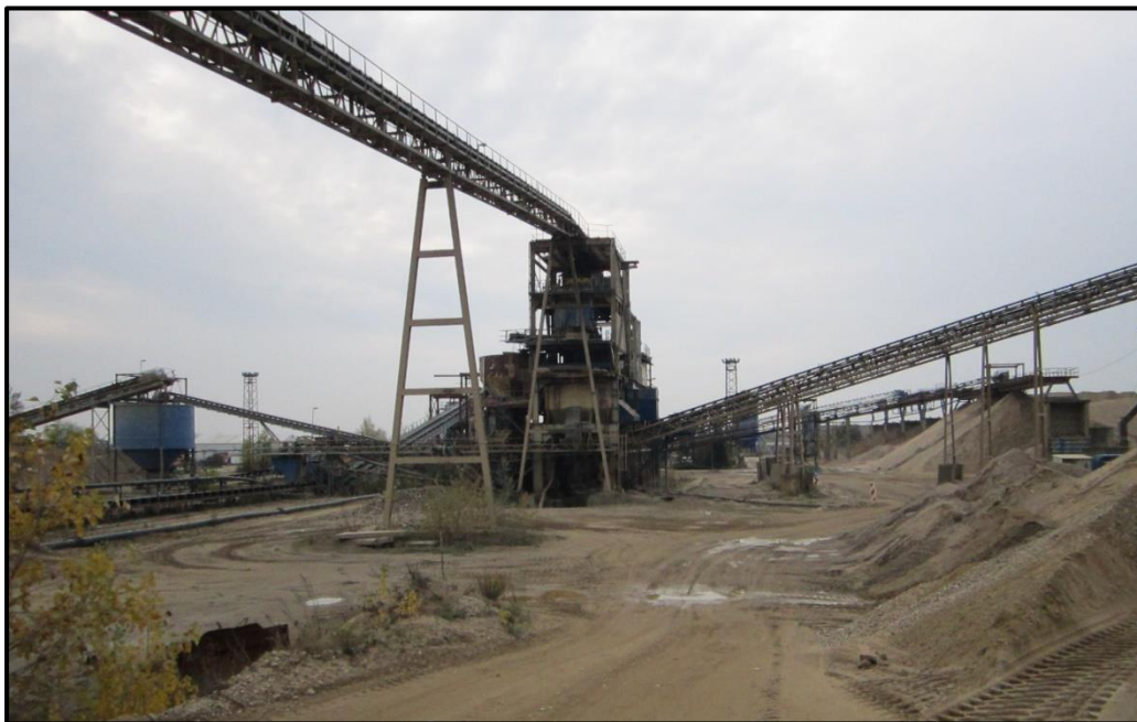
Abbildung 9: Aufbereitungskomplex Werk II
