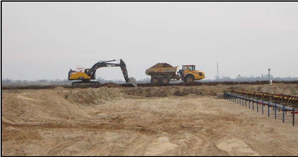
Abbildung 7: Abraumberäumung mittels Hydraulikbagger und Dumper
