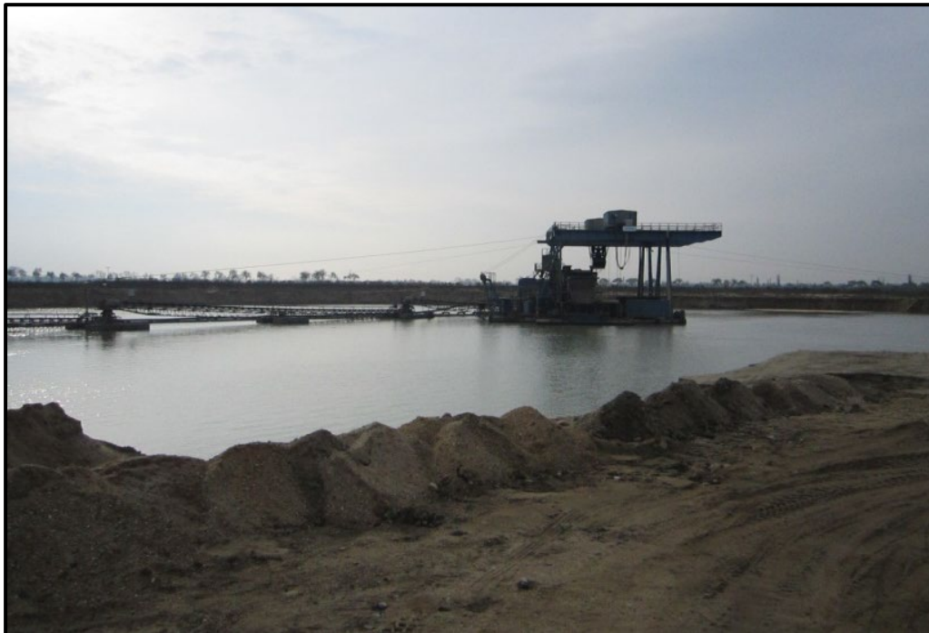
Abbildung 3: Geplante Gewinnungstechnologie - Nassbagger mit Schwimmbandanlage
