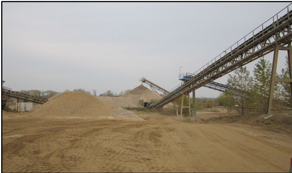
Abbildung 10: Rohkiesfreilager mit Unterflurabzug
