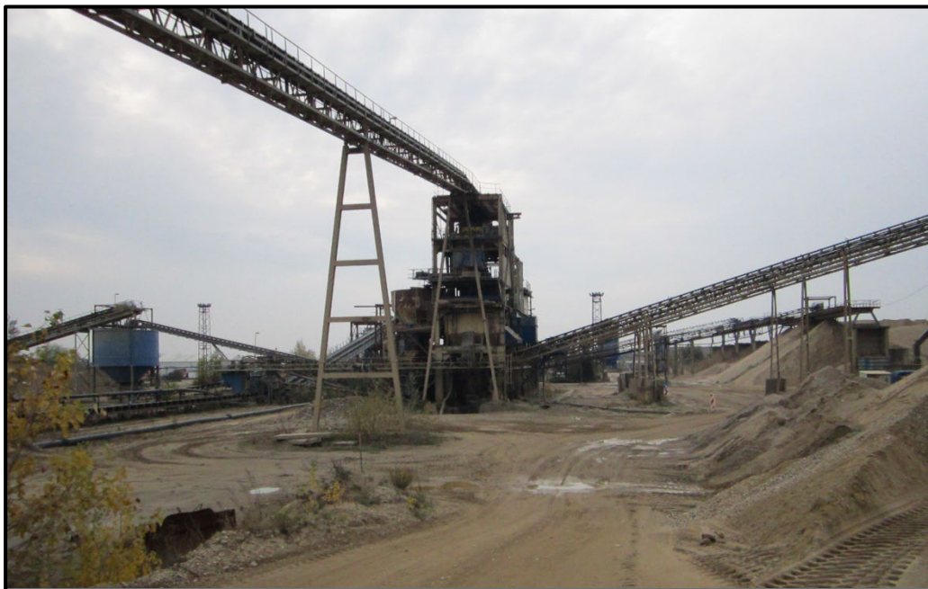
Abbildung 9: Aufbereitungskomplex Werk II
