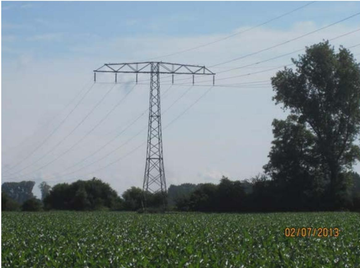
**Abbildung 2: Beseilung eines 110-kV-Einebenenmastes**
