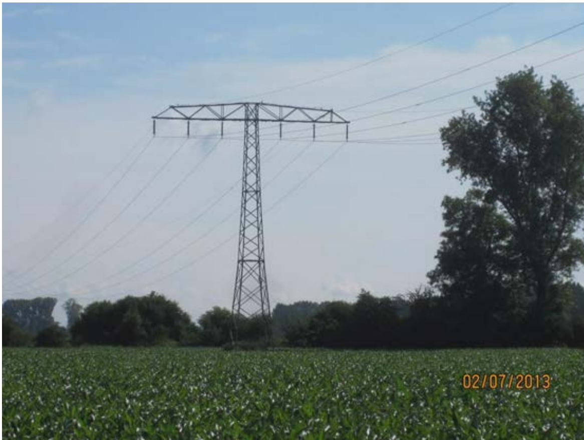
Abbildung 2: Beseilung eines 110-kV-Einebenenmastes
