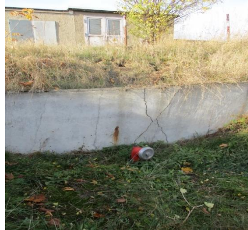
Feuerlöschbrunnen Agrargenossenschaft Mühlberg eG
