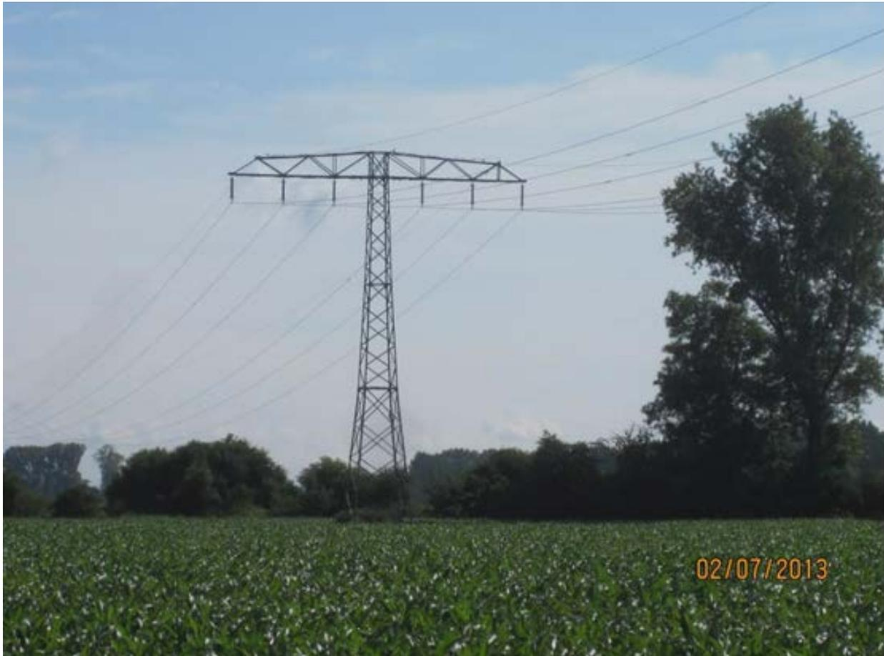
**Abbildung 2: Beseilung eines 110-kV-Ebenenmastes**
