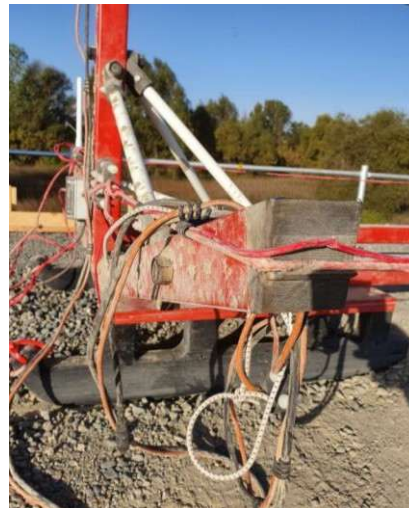
Bild A2-2: Nahaufnahme der Montage des Senderrahmens auf dem Schlitten
