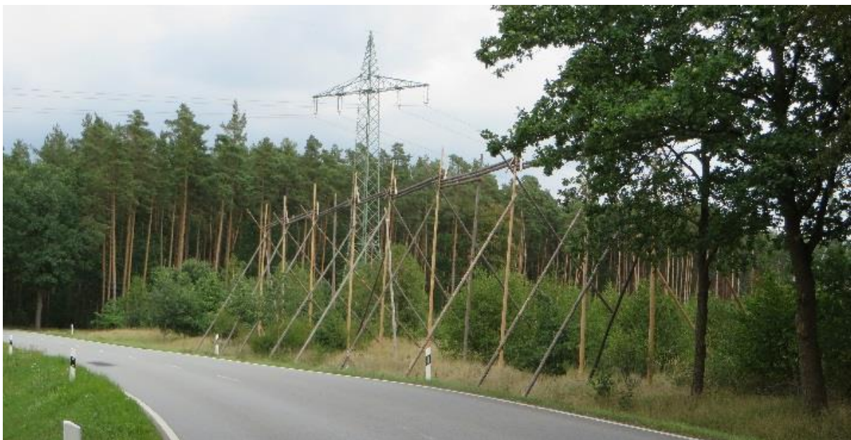
Abbildung 10: Schleifgerüst für Seilzug (Quelle: 50Hertz)
