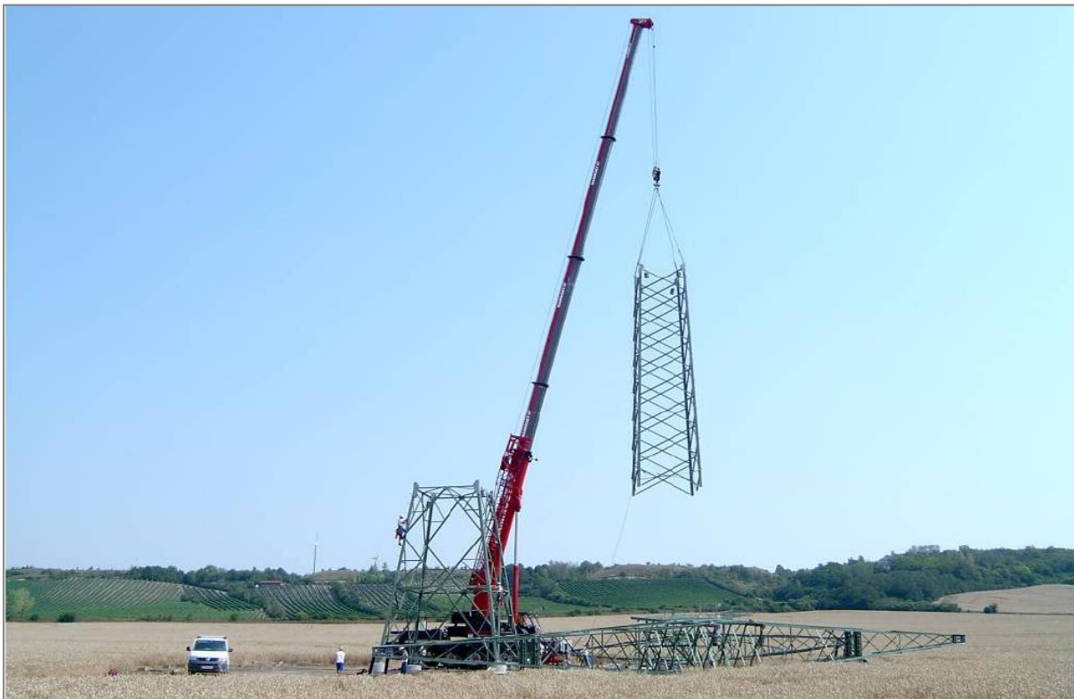
Abbildung 9: Maststocken mittels Mobilkran (Quelle: 50Hertz)
