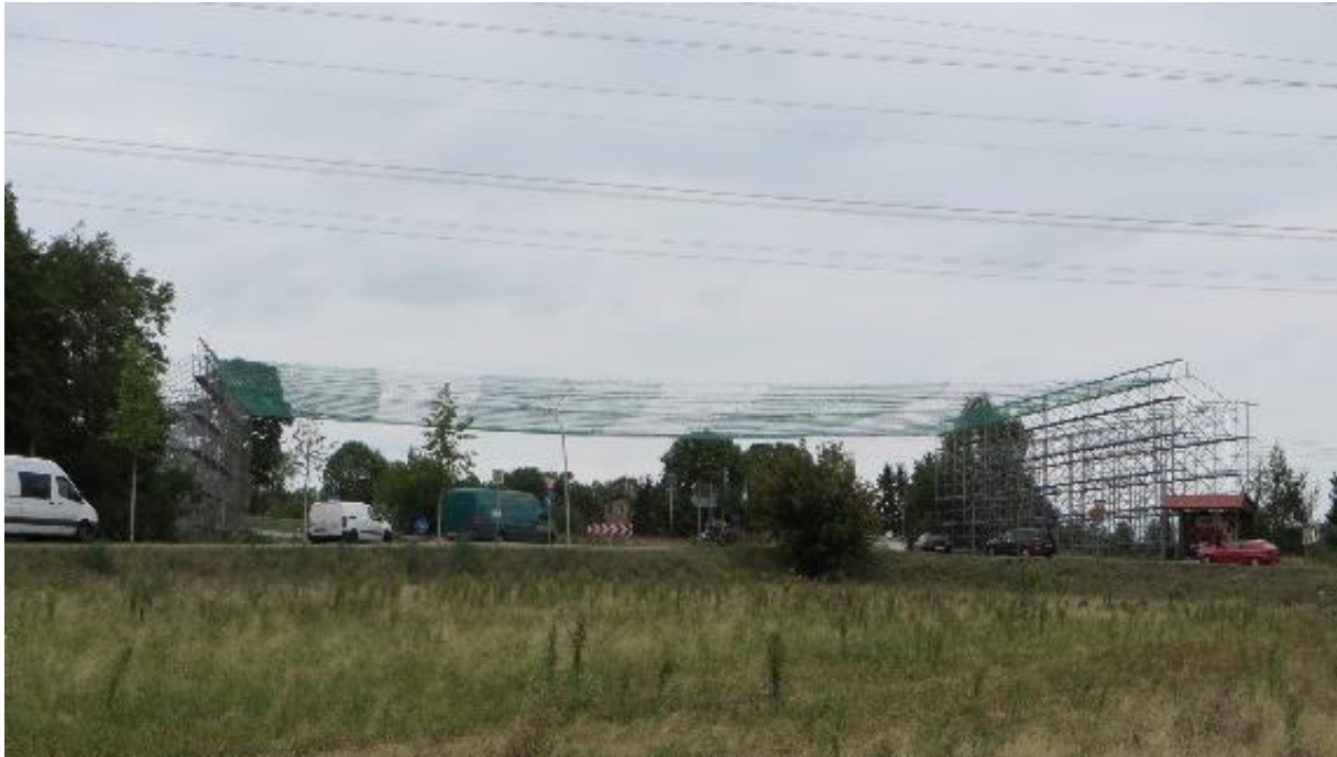
Abbildung 11: Schutzgerüst mit Netz für Seilzug (Quelle: 50Hertz)
