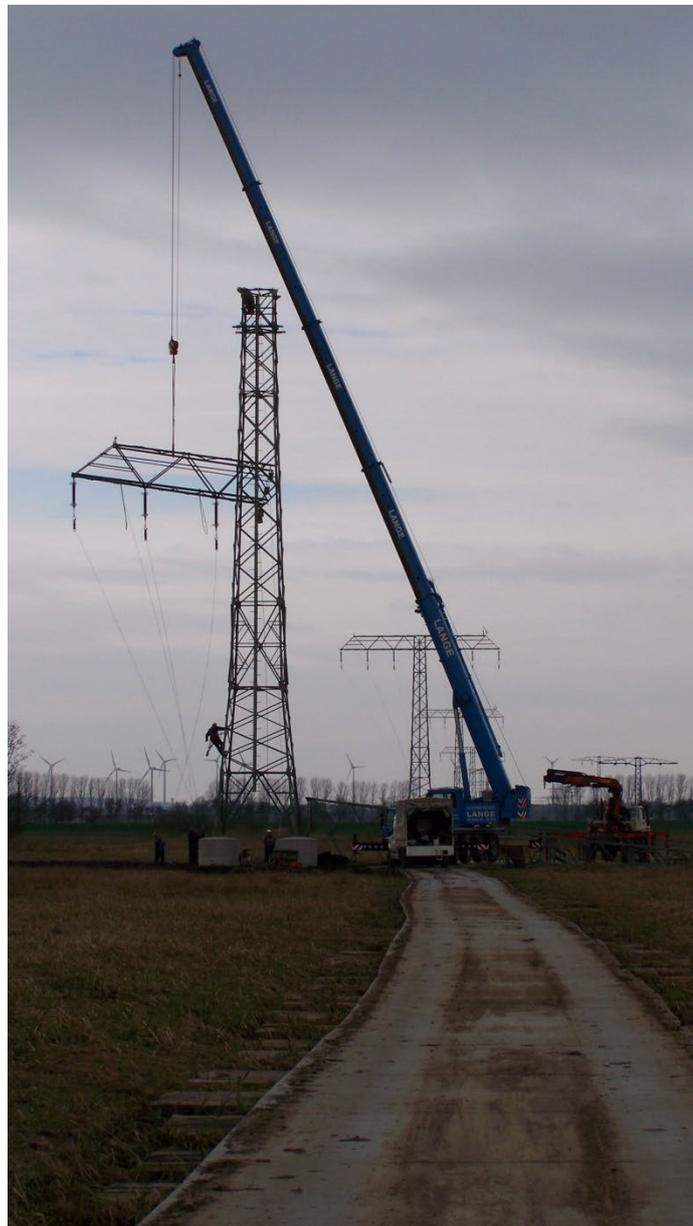
**Abbildung 14 Maststellen mittels Autokrans (Beispiel)**
