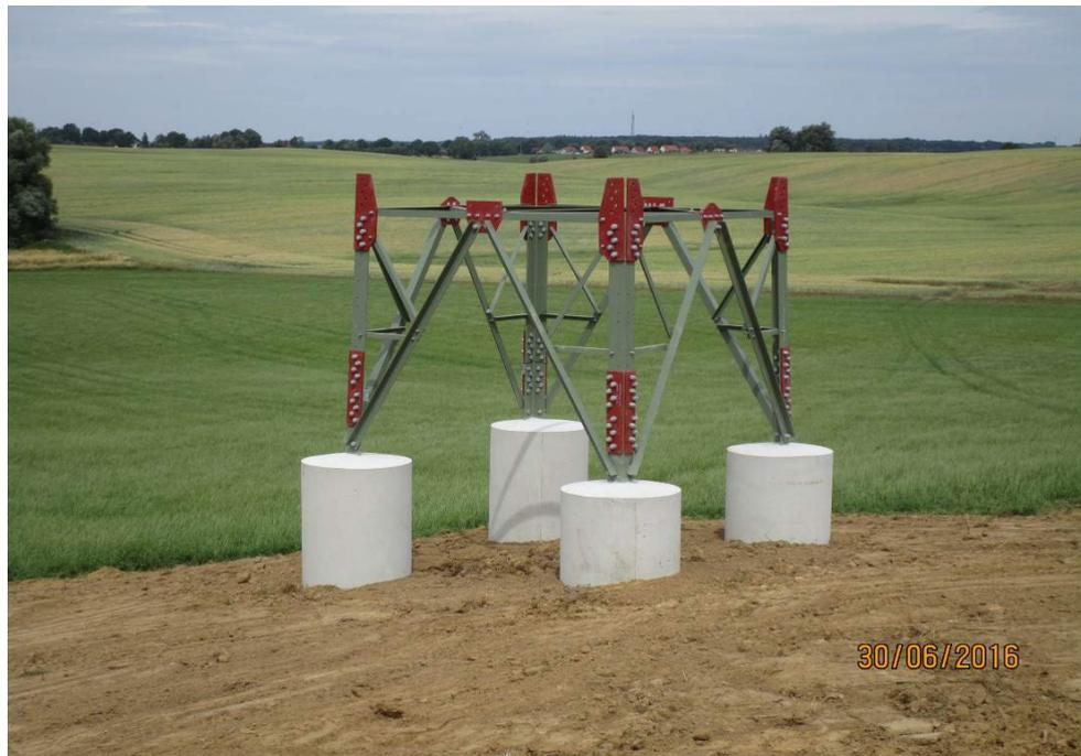
**Abbildung 11 Beispiel eines wiederverfüllten Plattenfundamentes (Beispiel)**
