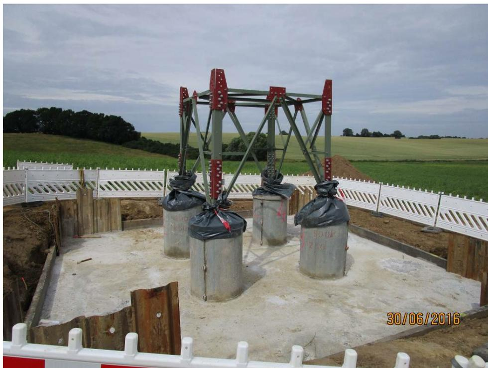
Abbildung 13 Baugrube mit Fundament (Beispiel)
