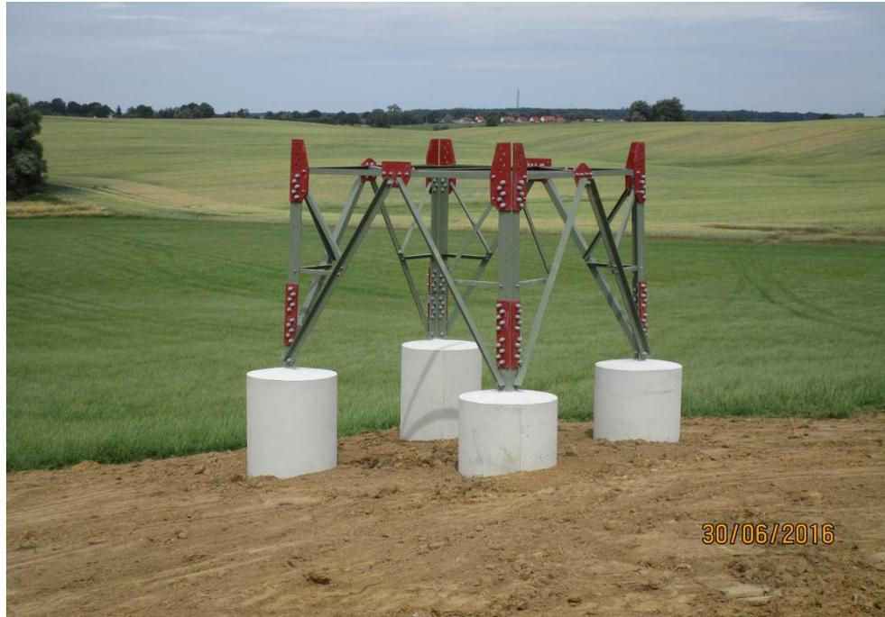
**Abbildung 11 Beispiel eines wiederverfüllten Plattenfundamentes (Beispiel)**
