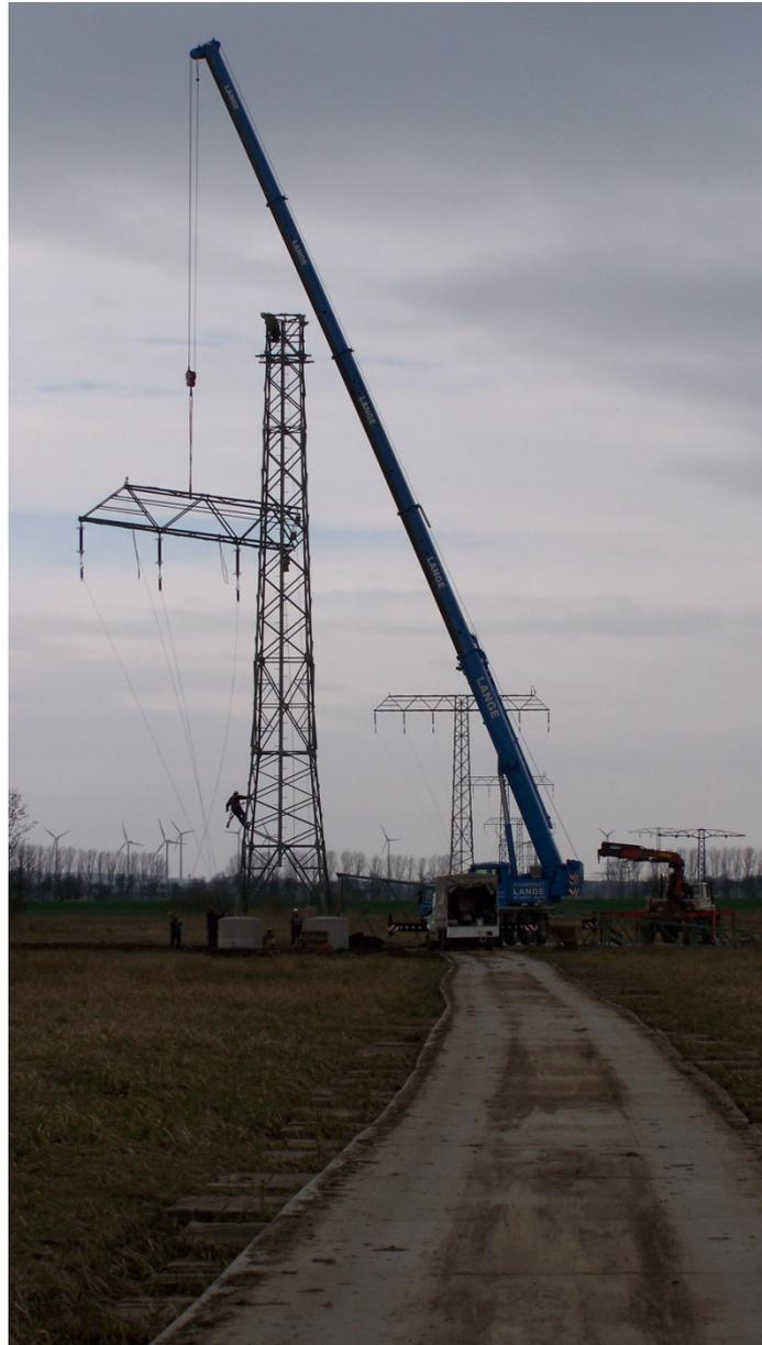
**Abbildung 14 Maststellen mittels Autokrans (Beispiel)**
