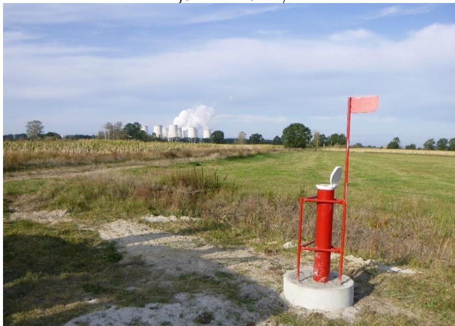
Neu errichtete Grundwassermessstelle 11931 östlich Jänschwalde, Blick nach Westen auf das Kraftwerk Jänschwalde (Foto: Denke, 24.09.2020)
