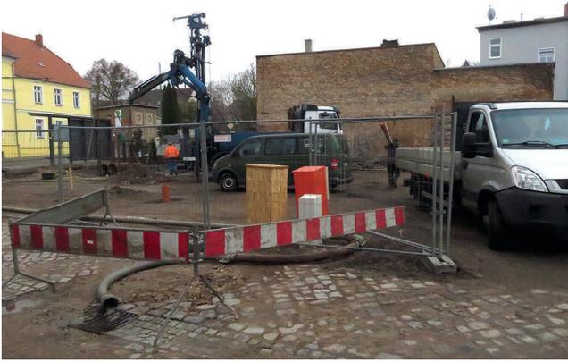
Abb. 6: Einleitung des abgepumpten Wassers in die Straßentwässerung
