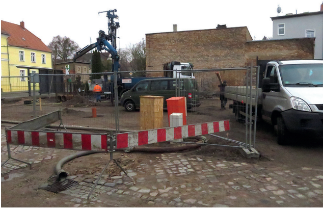
Abb. 6: Einleitung des abgepumpten Wassers in die Straßenentwässerung
