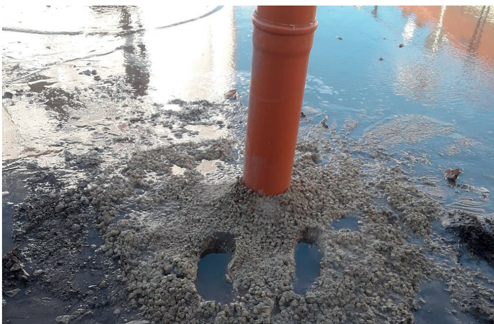
Abb. 3: Stand am 21. Januar 2021 bei CPT 1 vor Beginn der Arbeiten
