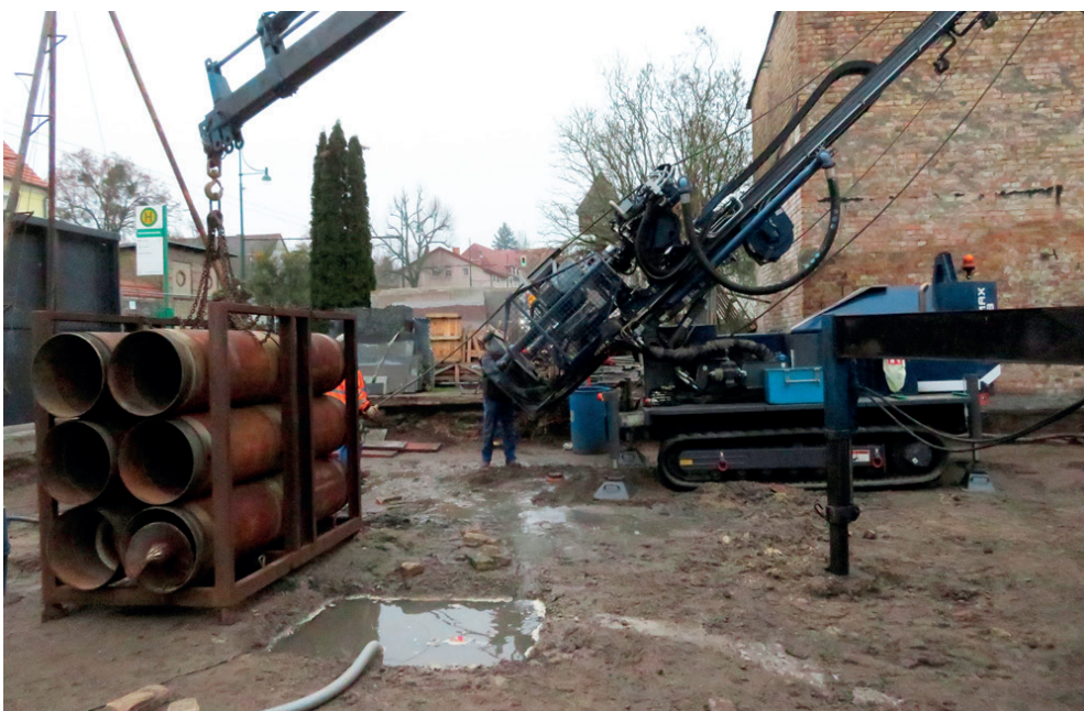
Abb. 5: Positionierung der Bohranlage auf CPT 1 am 27.01.2021
