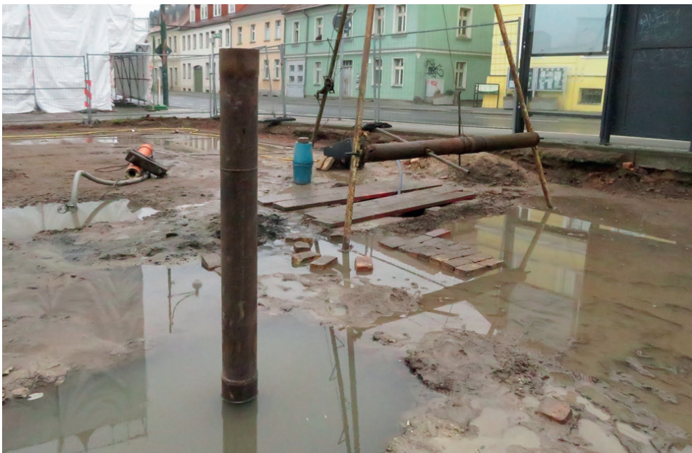
Abb. 4: Zustand am 24.01.2021. Sofortiger Wasseranstieg im GWLK 1 nach Abschalten der Pumpen. Im Vordergrund: Schutzverrohrung 159 mm auf Arteser bei CPT 1
