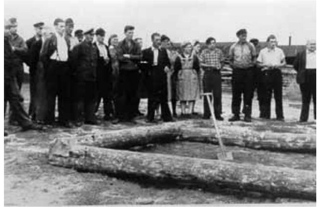
Abb. 18: Bewegender Augenblick – das Geviert vom 60 m tiefen „Neuen Förderschacht“ wird 1959 abgesteckt. Es sollte der letzte Schacht für die Braunkohlenförderung in der Mark Brandenburg sein (Bildarchiv R.-G. WEDDE).
