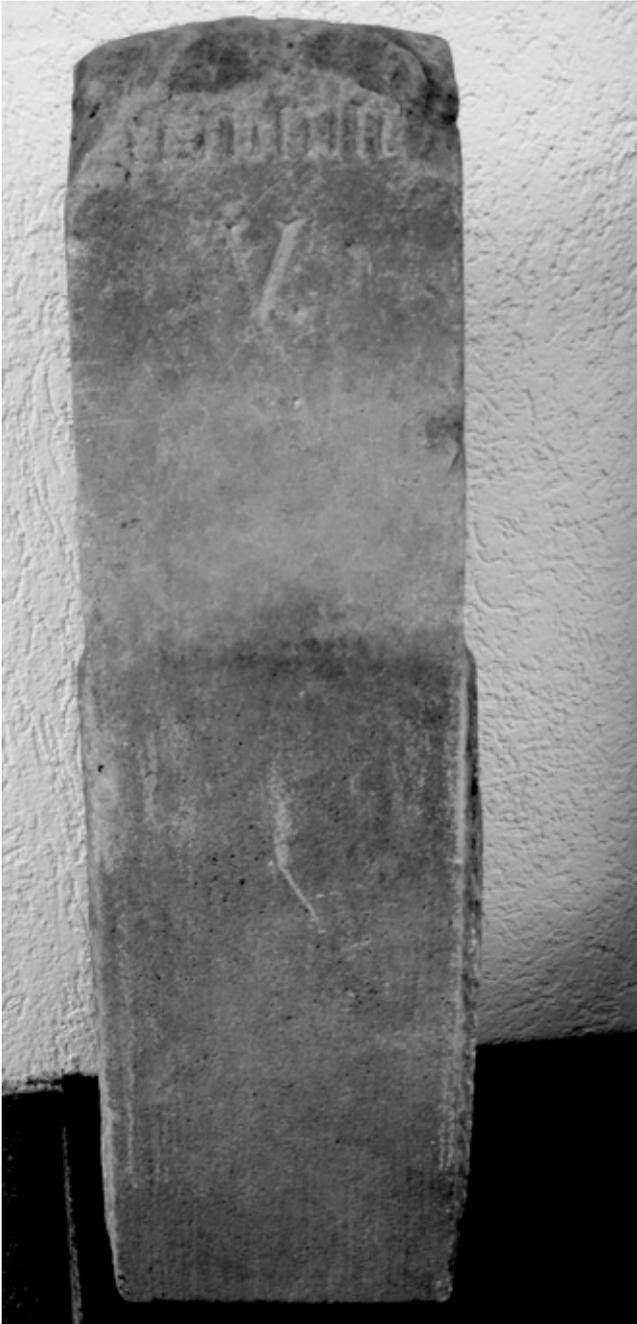
Abb. 31: Vollständig erhaltener Lochstein V vom Grubenfeld „Arminius“ – die untere, etwas breitere Hälfte wurde in die Erde gelassen, so dass an der Erdoberfläche nur die obere Hälfte sichtbar blieb (Foto: R.-G. WEDDE).
