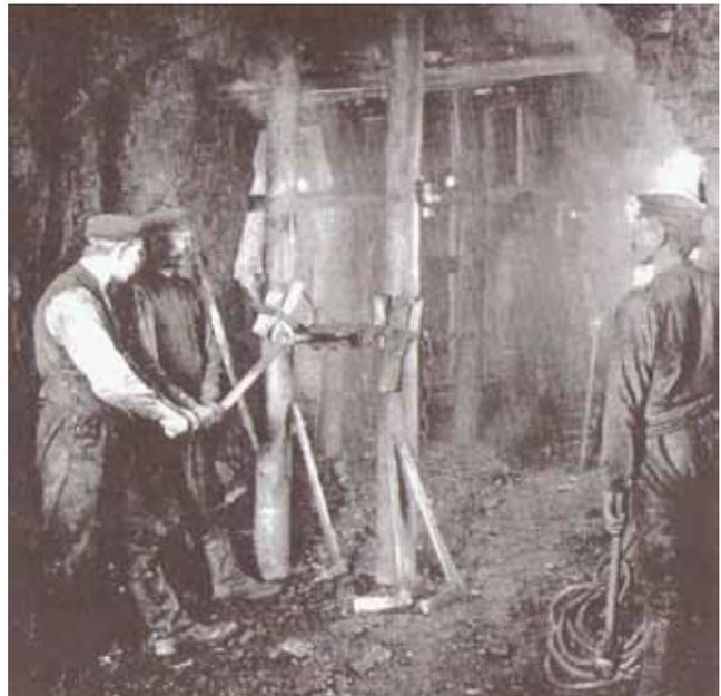
Abb. 178: Rauben der Zimmerung mit einer Raubspindel
