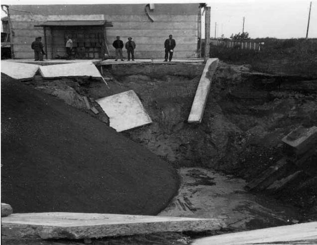
Abb. 186: Eingestürzter „Schacht der Jugend“ neben der B 112, Durchmesser: 21 m, Tiefe: 12 m
