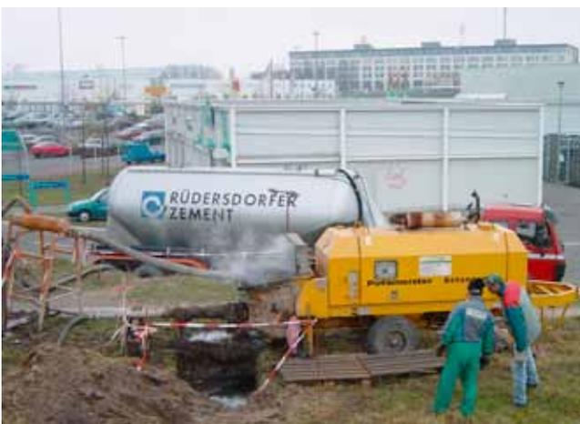
Abb. 139: Versatzanlage – Verpressung der Versatzsuspension in Hohlräume im Bereich des SMC (Foto: T. GÖBEL)
