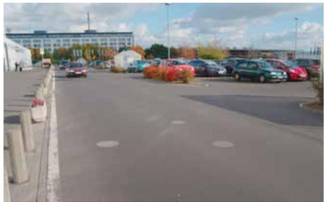
Abb. 140: Versiegelung der durchbohrten Asphaltdecke nach Beendigung der Erkundungsbohrungen am SMC (Foto: R.-G. WEDDE)
