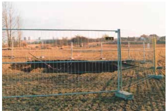
Abb. 41: Tagesbruch über der ehemaligen Grube „Cons. Vaterland“, Schacht „Körner“ (Foto: R.-G. WEDDE)
