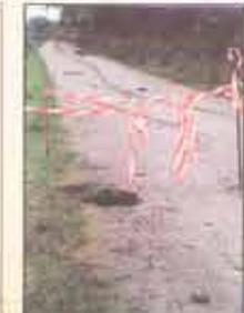
Abb. 14: Durch unvollständige Lückensicherung ausgefallene Tagesbrüche bei Braunkohlentiefbau, Durchmesser: 2m, Tiefe: 1,5m
