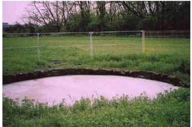
Abb. 185: Verplombung des Bruchs mit selbsterhärtender Versatzsuspension – anschließender Auftrag von Mutterboden (Foto: R.-G. WEDDE)
