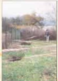
Abb. 10: Tagesbrüche über einer Abbaufläche in der Längsgrube in Froscher (Dorf) Durchmesser: 10m, Tiefe: 3m
