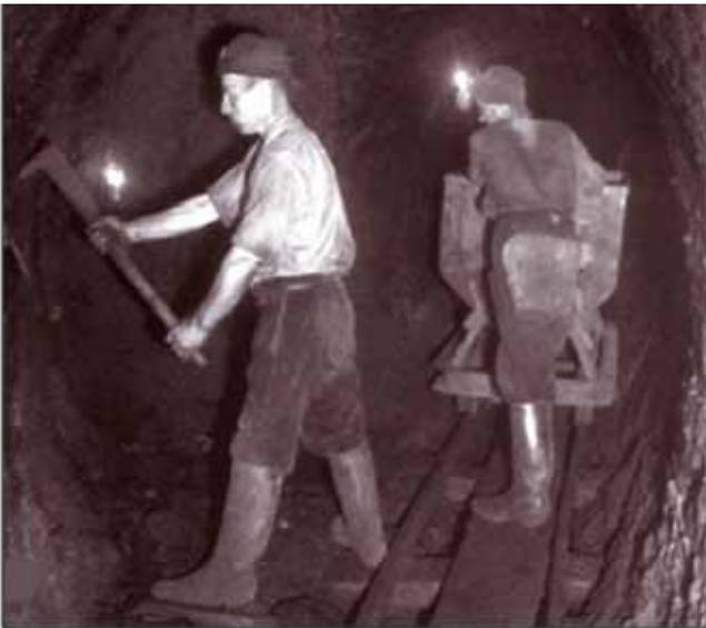
Abb. 46: Keilhauenarbeit in einer Entwässerungsstrecke (Wölbstrecke), rechts Bergmann mit Arschleder (aus: SCHOSSIG et al. 2007, Kartenteil S. 58)
