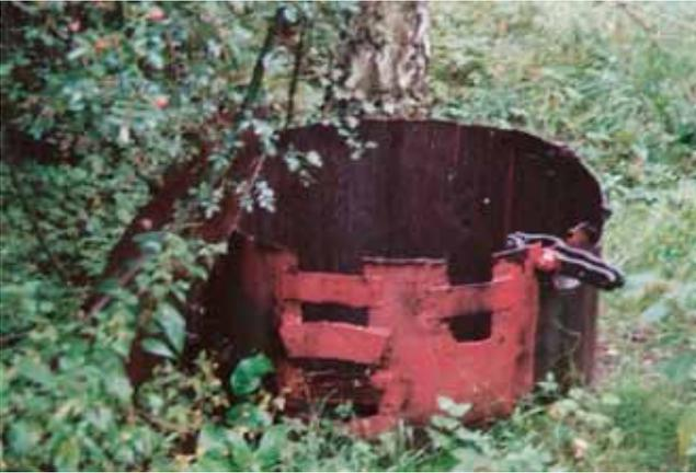
Abb. 174: Schachtkopf vom Versuchsschacht „Lawitz II“ (5 mm starke Eisenverrohrung, lichter Durchmesser: 1 100 mm), 1995 (Foto: R.-G. WEDDE)
