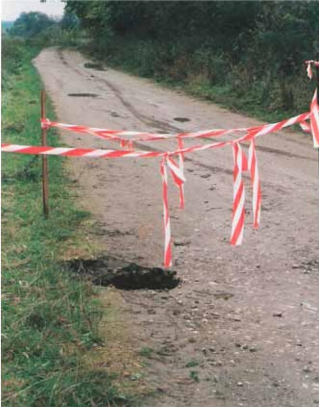
Abb. 182: Braunkohlengrube „Max“ und „Willenbücher“ bei Bollersdorf – gewölbeförmiger Tagesbruch unter Fahrweg – deutlich ist die Reifenspur eines schweren Fahrzeugs erkennbar (Foto: R.-G. WEDDE).
