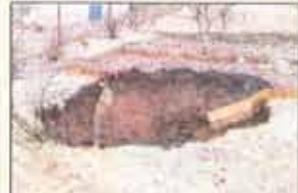
Abb. 9: Tagesbruch über einem Primärlotraum in der Längsgrube in Froscher (Dorf) Durchmesser: 10m, Tiefe: 3m
