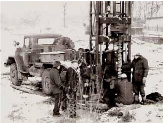
*Abb. 112: Schneckenbohrgerät SIL-LBU: Schachterkundung durch den VEB Braunkohlenbohrungen und Schachtbau Welzow am Lüdersdorfer Weg, Dezember 1978 (Foto: R.-G. WEDDE)*
