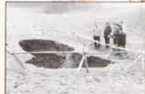
Abb. 7: Tagesbruch über einem Querschlag auf hochdruckfesten Schichten in Froscher (Dorf) Durchmesser: 10m, Tiefe: 3m
