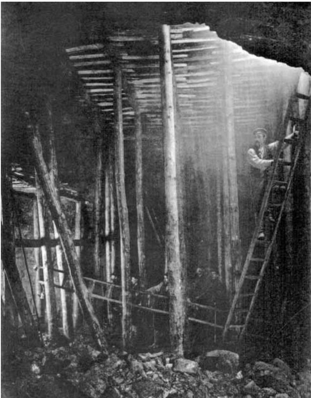
Abb. 54: Im Abbau „unter Tage“: Die Grundfläche einer Kammer betrug ca. 25 m<sup>2</sup>, die Höhe bis 4 m und das Abbauvolumen bis 100 m<sup>3</sup> (Bildarchiv R.-G. WEDDE).
