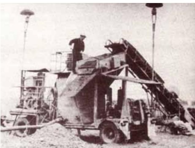
*Abb. 113: Versatzanlage des VEB Braunkohlenbohrungen und Schachtbau Welzow mit Aufgabeband und Schwingsieb um 1978 (Bildarchiv R.-G. WEDDE)*
