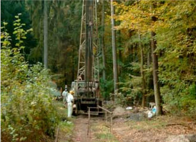
Abb. 58: Auto-Bohrgerät URB 2,5A im Einsatz: Hohlräume unter dem Wanderweg werden durch Bohrungen erkundet (Foto: T. GÖBEL).
