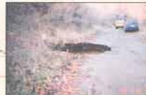
Abb. 5: Tagesbruch über dem Primärlotraum in der Längsgrube der Längsgrube in Froscher (Dorf) Durchmesser: 10m, Tiefe: 3m
