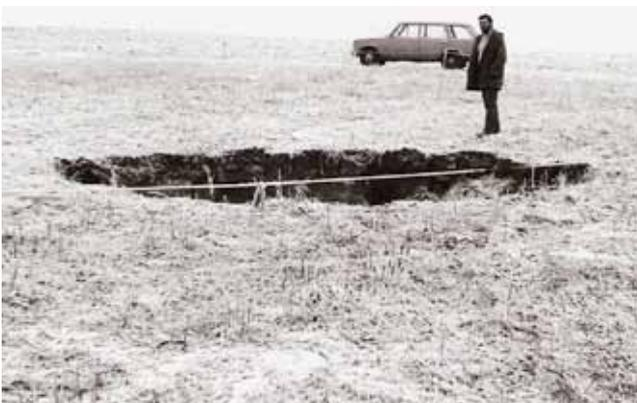
Abb. 8: Tagesbruch Braunkohlengruben „Max“ und „Willenbücher“ Bollersdorf bei Strausberg, Durchmesser: 4,5 m; Tiefe: 2,5 m
