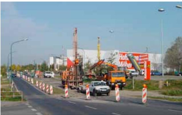
Abb. 138: Erkundungsbohrungen werden zum Nachweis von Hohlraum im Bereich des SMC geteuft (Foto: T. GÖBEL).
