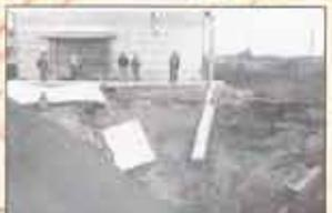
Abb. 8: Schachtelrinne an der Tagesoberfläche 172 bei Froscher (Dorf) Durchmesser: 10m, Tiefe: 3m
