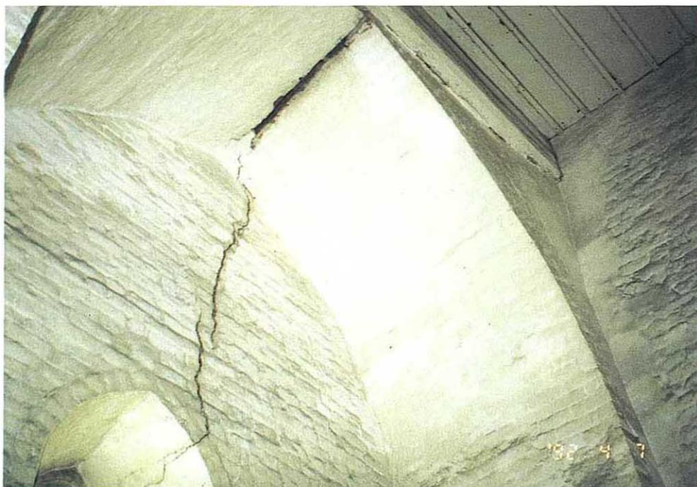
Abb. 5 Turmsüdwand (innen), Rupturverlauf. Kluft im Spitzbogen 7 cm geöffnet. Foto: R. Meier
