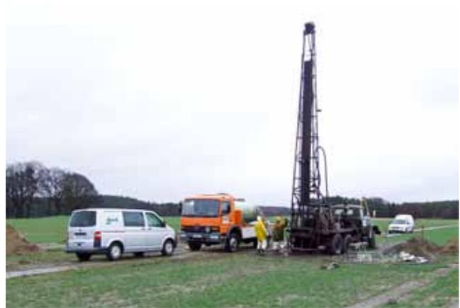
Abb. 21: Schachterkundung am Ortsverbindungsweg Döllen – Luisenhof – Dannenwalde durch die Bergsicherung und Baugrundsanie rung GmbH Frankfurt (Oder) mit dem Bohrgerät URB 2,5A (Foto: R.-G. WEDDE)
