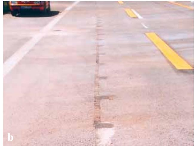
Abb. 32a – b: Erkundungs- und Sicherungsmaßnahme im Bereich der BAB A 24 Hamburg–Berlin in der Nähe des Autobahndreiecks Wittstock – a: Bohrerkundung mit dem Bohrergerät VSB 2500, b: verfüllte und versiegelte Bohrlöcher (Fotos: W. SEIFERTH)
