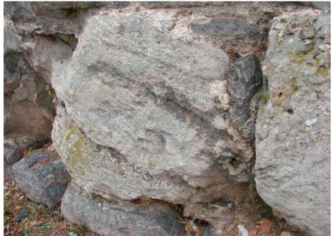
Abb. 8: Block des vom Höör-Sandstein völlig abweichend patinierenden Tertiär-Sandsteins. Auffällig ist die wenig deutliche scharfkantige Quaderform, auf deren oberen Fläche noch grobe Bearbeitungsspuren vorhanden sind (Bildausschnitt 70 cm).
