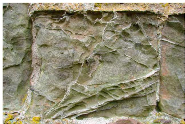
Abb. 3: *Stark an der Oberfläche angewitterter Block an der Westseite des Turms - deutlich treten die witterungsbeständigen Quarzadern hervor, die auf die thermische Beeinflussung des Sandsteins hinweisen (Originalgröße des Bildausschnitts ca. 50 cm).*
