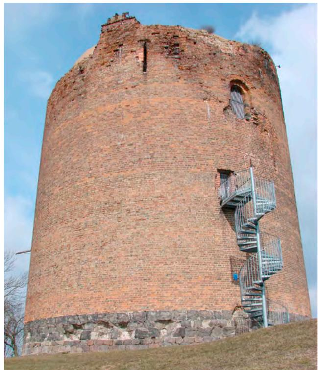
Abb. 1: Turm zu Stolpe mit den drei Reihen verschiedener Sandsteine. Im Detailbild die drei Einschüsse von Granaten aus dem 2. Weltkrieg, die einen Einblick in das Mauerinnere ermöglichen.
