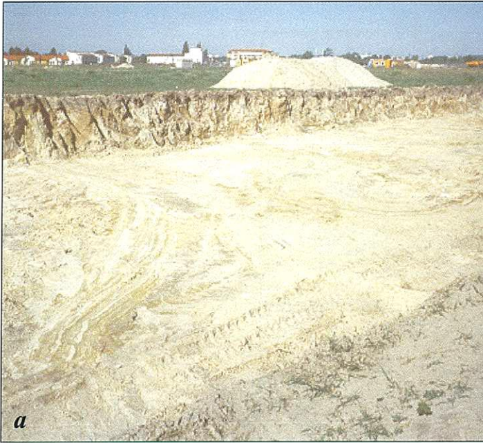
Abb. 3 Bilder aus der Aufstiegsstrukturzone von „Hönow - Süd“ a und b: diapirartige Aufstiegsstrukturen im Bereich der Trasse für die neue Strasse „Am Wall“ (Draufsichten)
