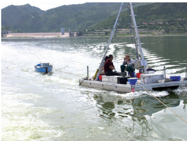
Abb. 3 Die Probenahmeplattform wird an den nächsten Bohrpunkt gezogen. Im Hintergrund ist der Schwergewichtsdamm des GR zu sehen (Foto: D. Acksel)
