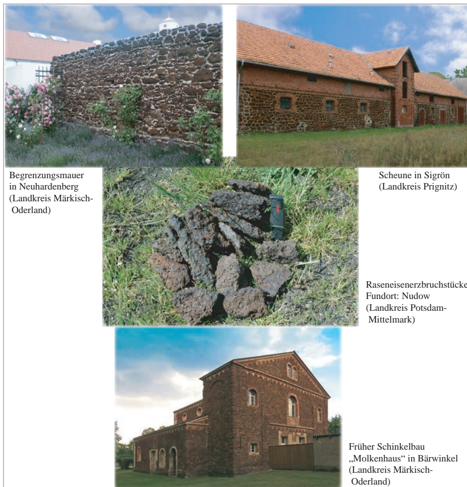
Abb. 9: Beispiele für den Einsatz von Raseneisenerz für Bauzwecke (Fotos: E. WETZEL)
