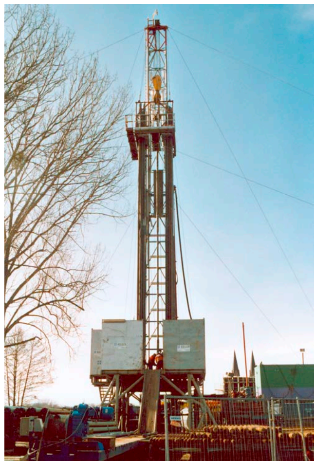
Abb. 1: Anlage der Bohrung Neuruppin Sol Nn S2/2006 (Foto: M. GÖTHEL 2007)
