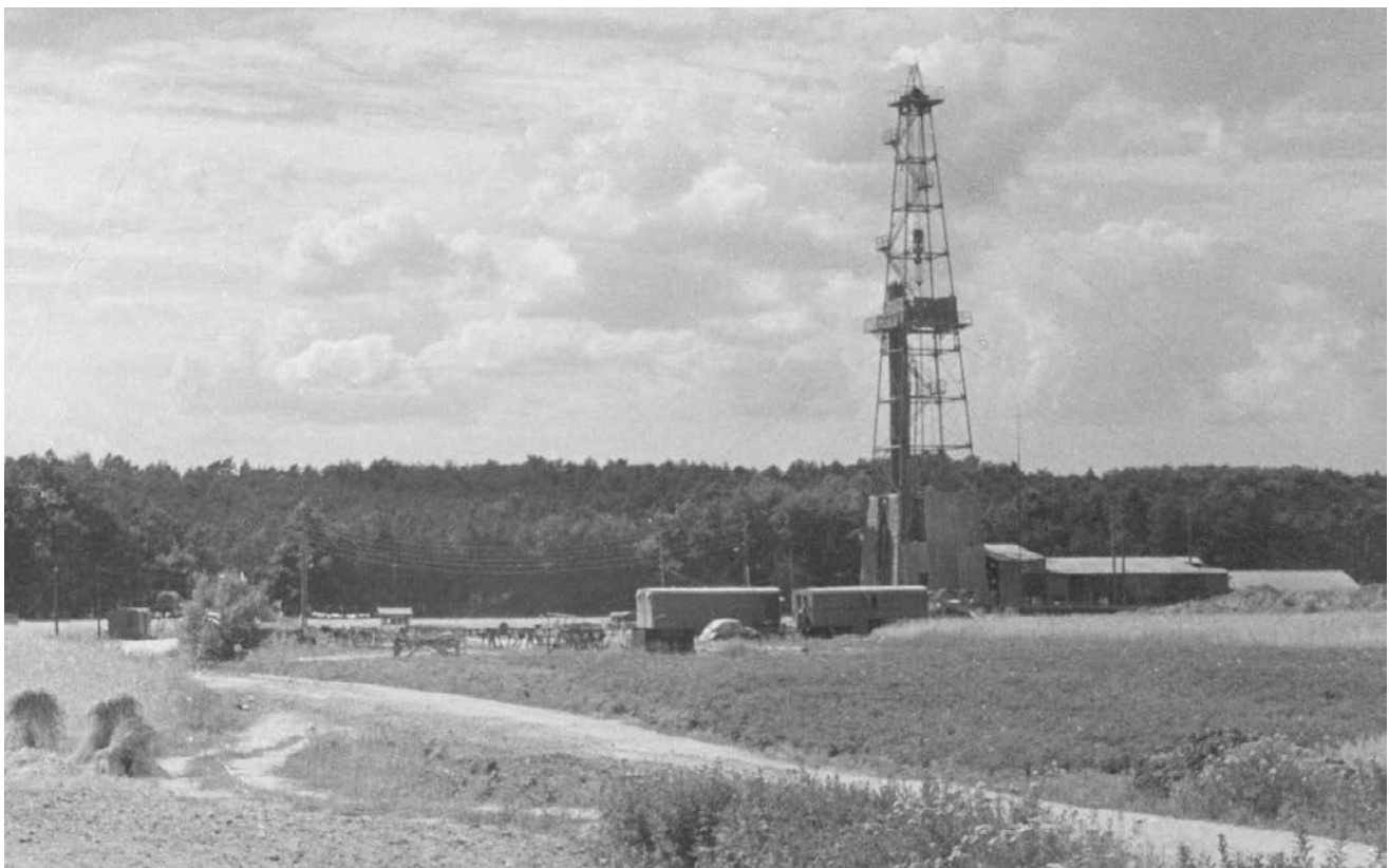
Abb. 1: In den sechziger Jahren bestimmte die Erdöl-/Erdgas-Erkundung mit der Bohranlage 5D-Uralmasch die landschaftliche Silhouette der Lausitz; hier zu sehen die Bohrung Guben E Gu 2/62 bei Schlagsdorf (Foto: K. GRUNERT 1962).
