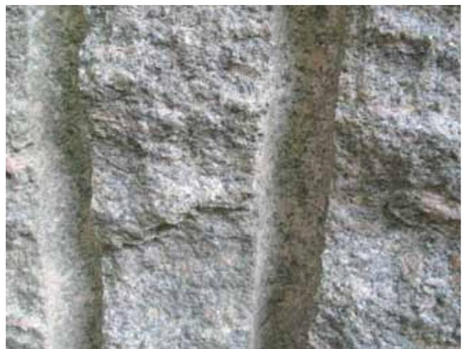
Abb. 2: Reste von Bohrlochresten an der Spaltfläche
