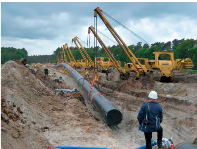
Abb. 7: Ein verschweißter Rohrstrang wird verlegt (bei Grünheide-Hangelsberg, Foto: O. JUSCHUS)
