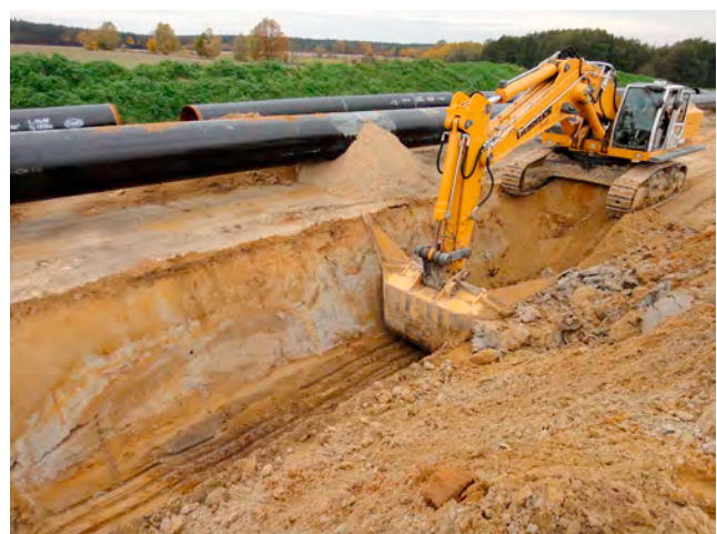
Abb. 5: Der Grabenbagger beim Ausheben des Leitungsgrabens südlich von Heideblick-Weißack (Foto: O. JUSCHUS)
