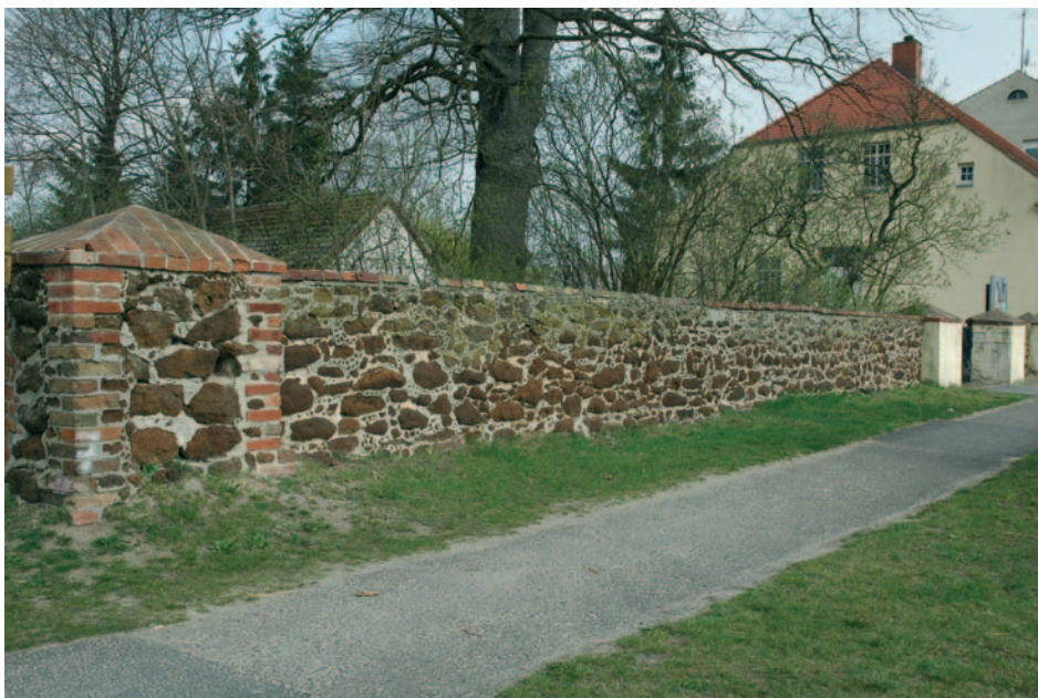
Abb. 5 Mauer aus Raseneisenerz am Pfarramt Neuhausen (Kreis Märkisch-Oderland) Foto: F. Ludwig, 2005
