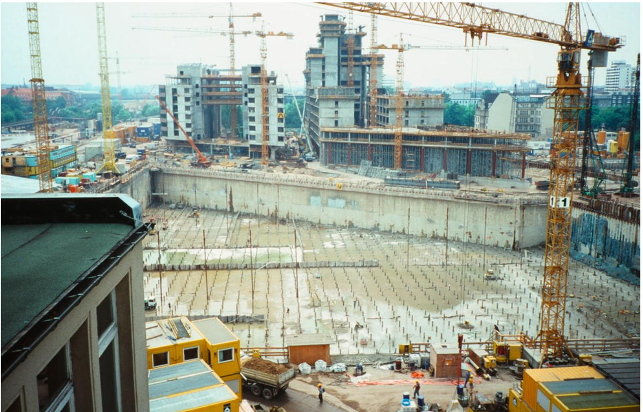
Abb. 18: Fertiger Trog nach Abpumpen des Grundwassers (Foto: ALEXANDER LIMBERG)
