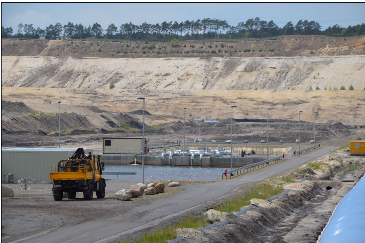
Foto 9: Technische Bauwerke - Wasserbecken der Hauptwasserhaltung im Tagebautiefsten
