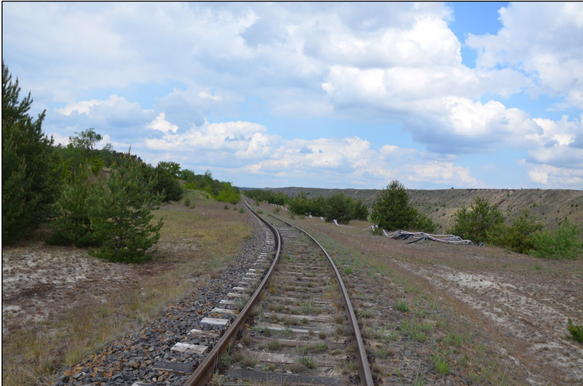
Foto 8: Bereich der rückzubauenden Gleiszufahrt
