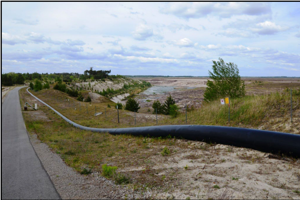
Fotos 13: Rückbau von Infrastruktur innerhalb der Sicherheitslinie
