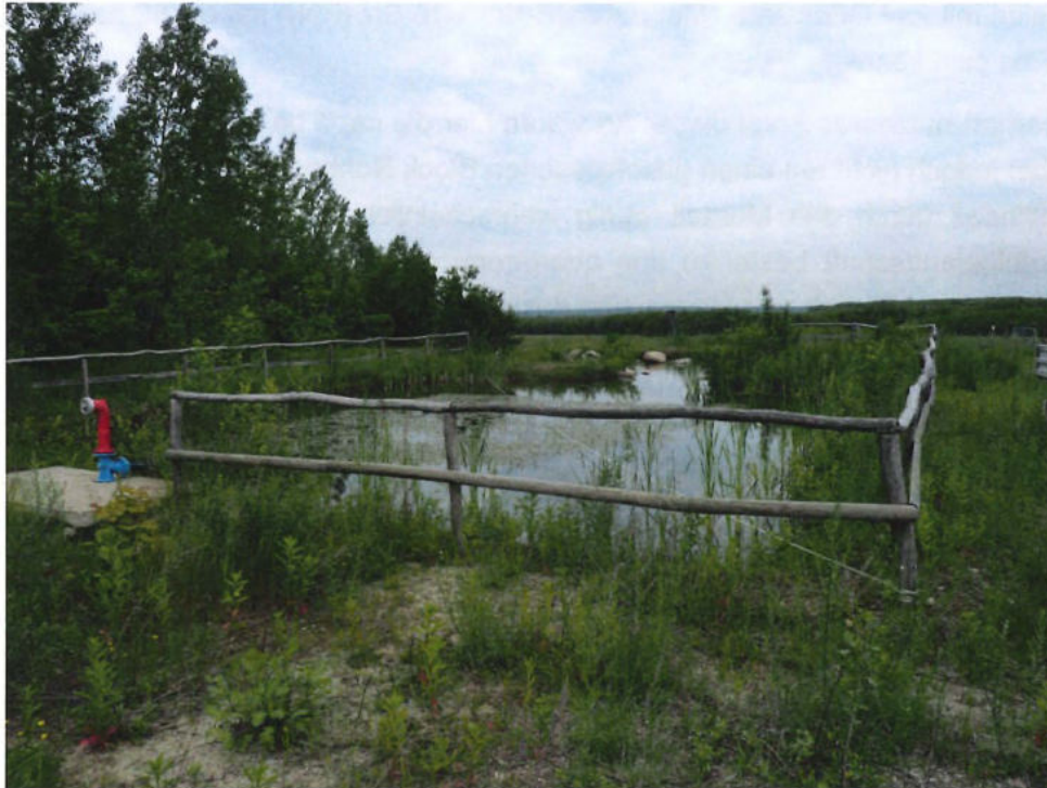
Foto 5. Naturnah gestalteter Löschteich, welcher neben seiner Aufgabe als Wasserreserve ökologische Funktionen erfüllt (Kippe des Tagebaus Welzow Süd; 10.06.2013).
