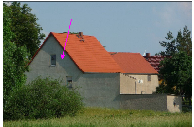
Abbildung 5: IO 1-V, Altenau, Dorfstraße 45 (von Nordwest)
