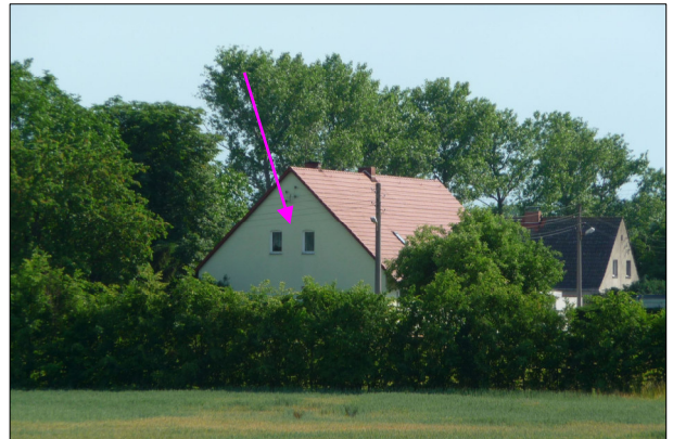
Abbildung 7: IO 3-V, Borschütz, Berliner Straße 14 (von Nordost)
