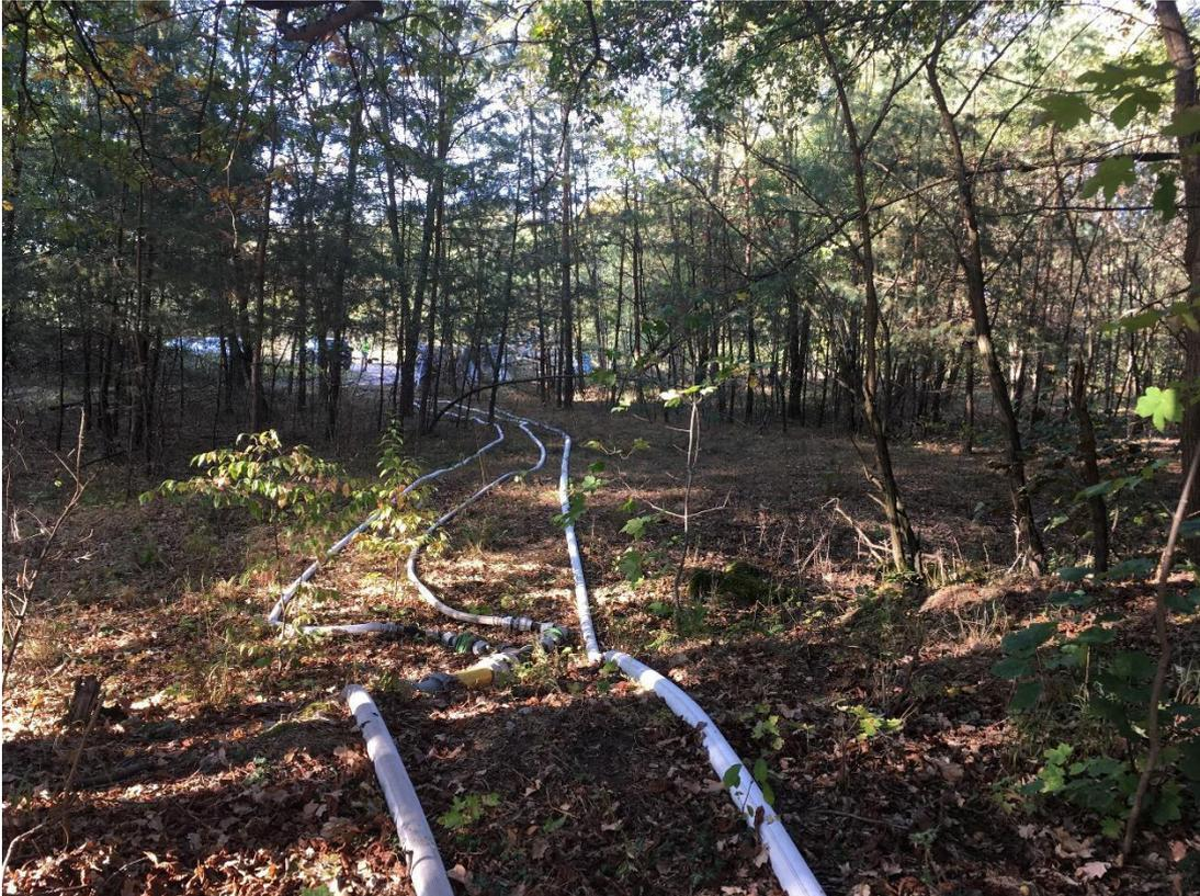
**Abbildung 9: Leitung für das Abpumpwasser**
