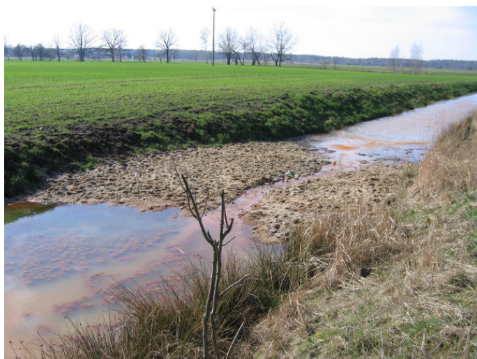
Foto 9: Zur Wasserstandserhöhung bzw. Abflussreduzierung eingebrachter Querverbau am südlich gelegenen Hauptentwässerungsgraben (März 2007)
