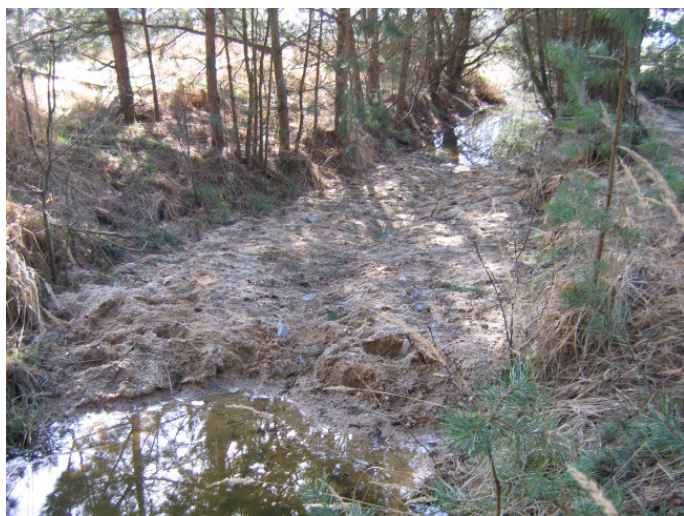
Foto 8: Zur Wasserstandserhöhung bzw. Abflussreduzierung eingebrachter Querverbau am nördlich verlaufenden Graben (März 2007)
