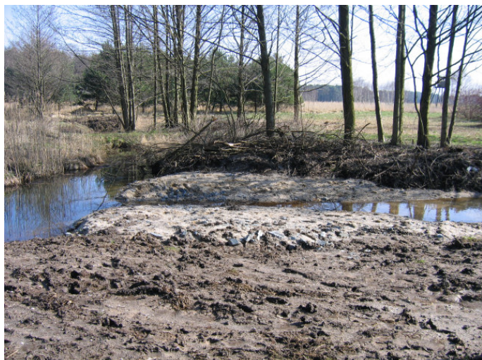
Foto 7: Zur Wasserstandserhöhung bzw. Abflussreduzierung eingebrachter Querverbau am westlich verlaufenden Graben (März 2007)
