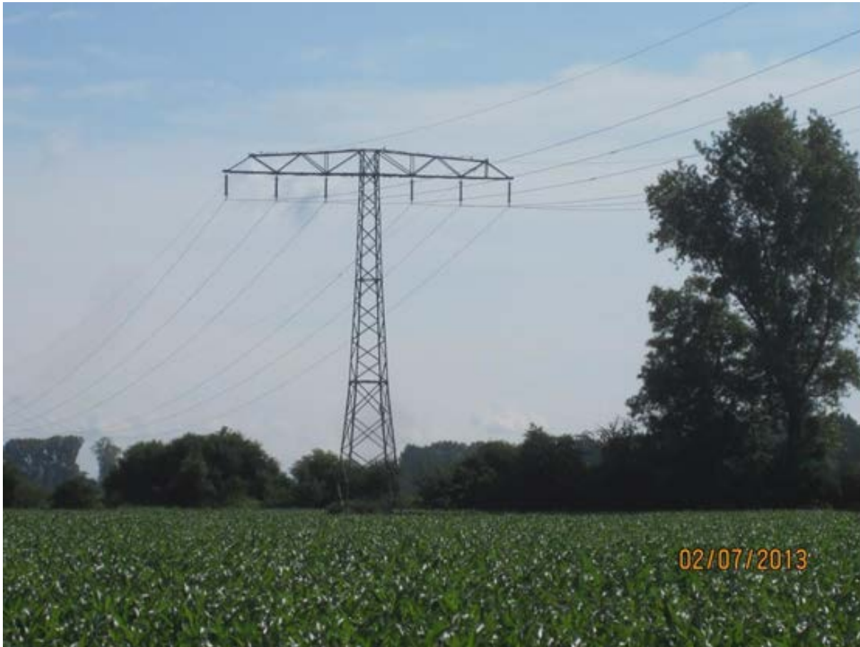
Abbildung 3: Beseilung eines 110-kV-Einebenenmastes
