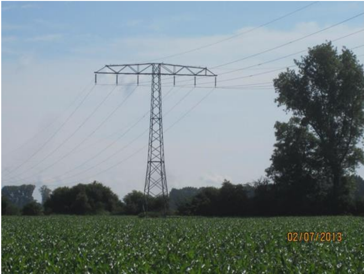
Abbildung 3: Beseilung eines 110-kV-Einebenenmastes
