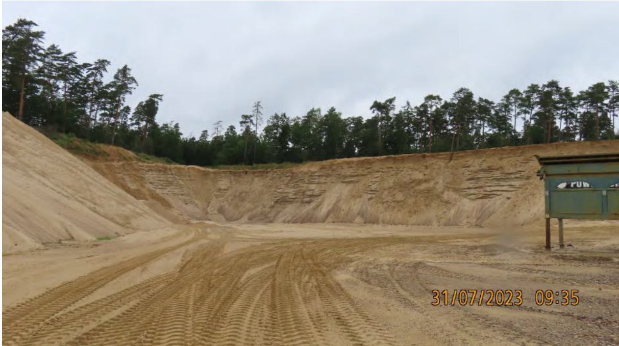
Abb. 2: Nordwestliche Trockenschnittböschung, Blick nach NW
