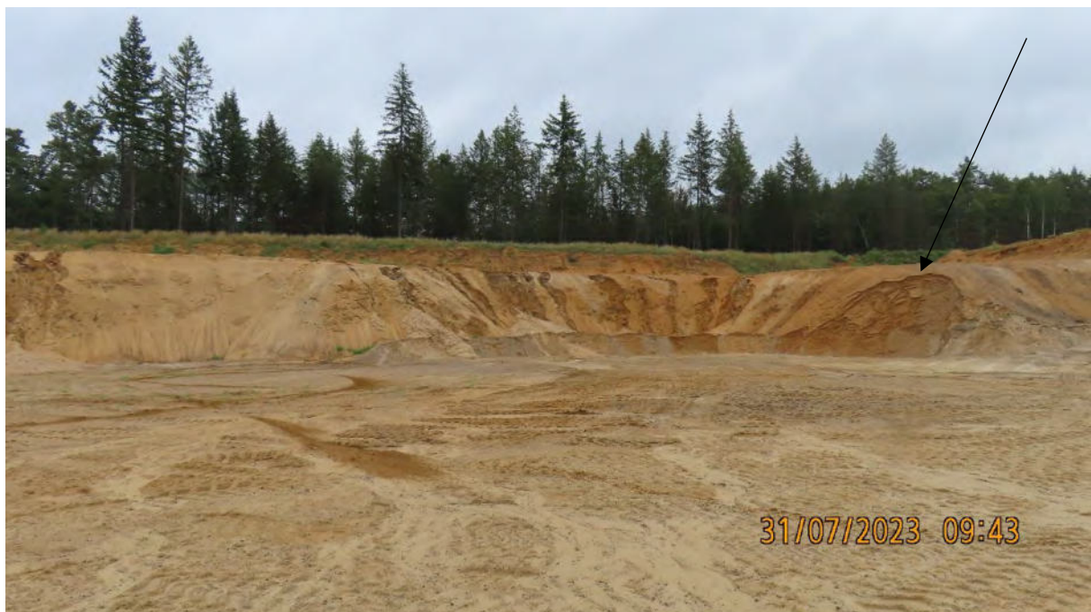
Abb. 5: Nordöstliche Trockenschnittböschung, Blick nach N
