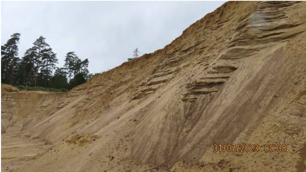
Abb. 4: Nordwestliche Trockenschnittböschung, Detail, Blick nach W
