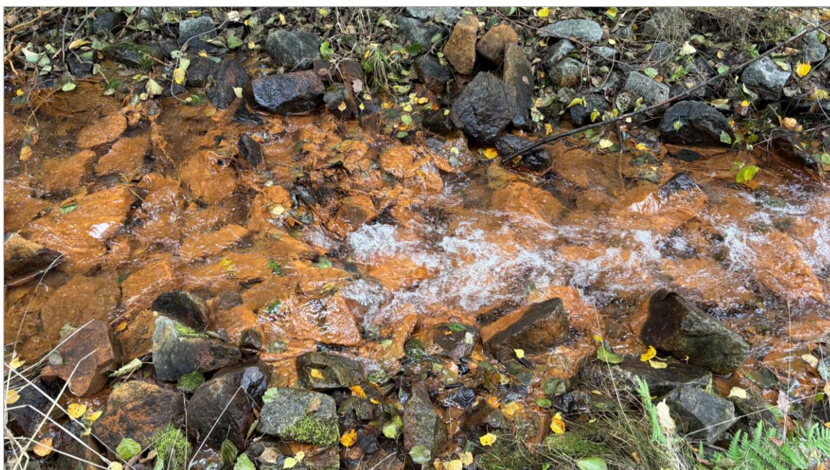
Abbildung 5.12: Großsee – Zustand der Einleitkaskade (Oktober 2025)
