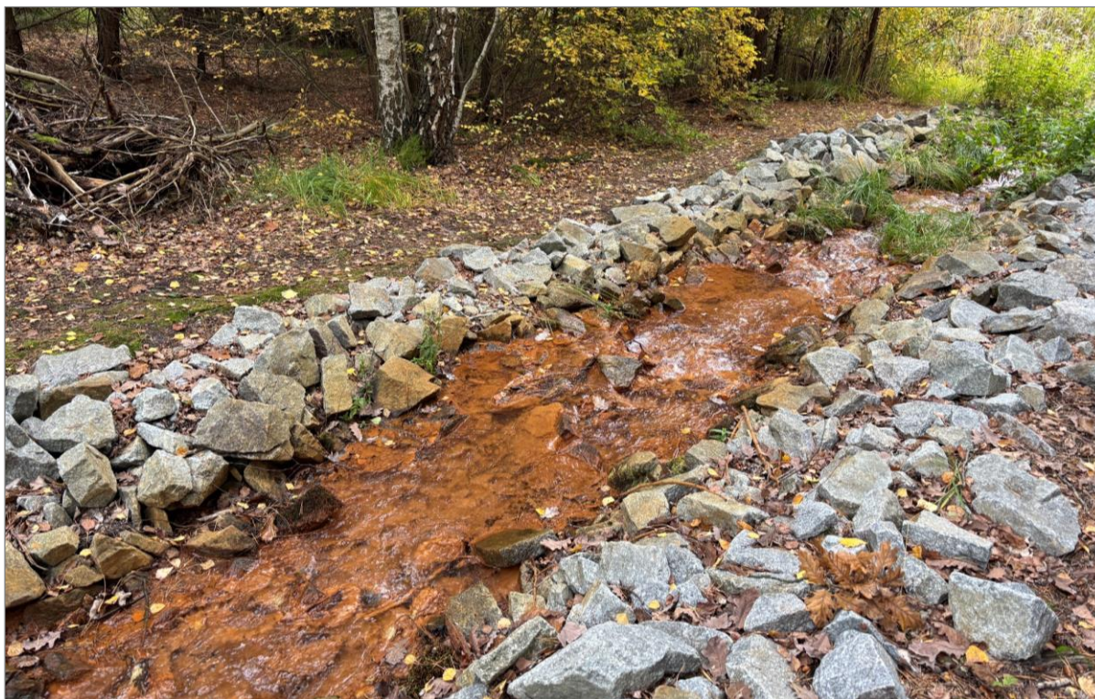
Abbildung 5.19: Kleinsee – Zustand der Einleitkaskade (Oktober 2025)
