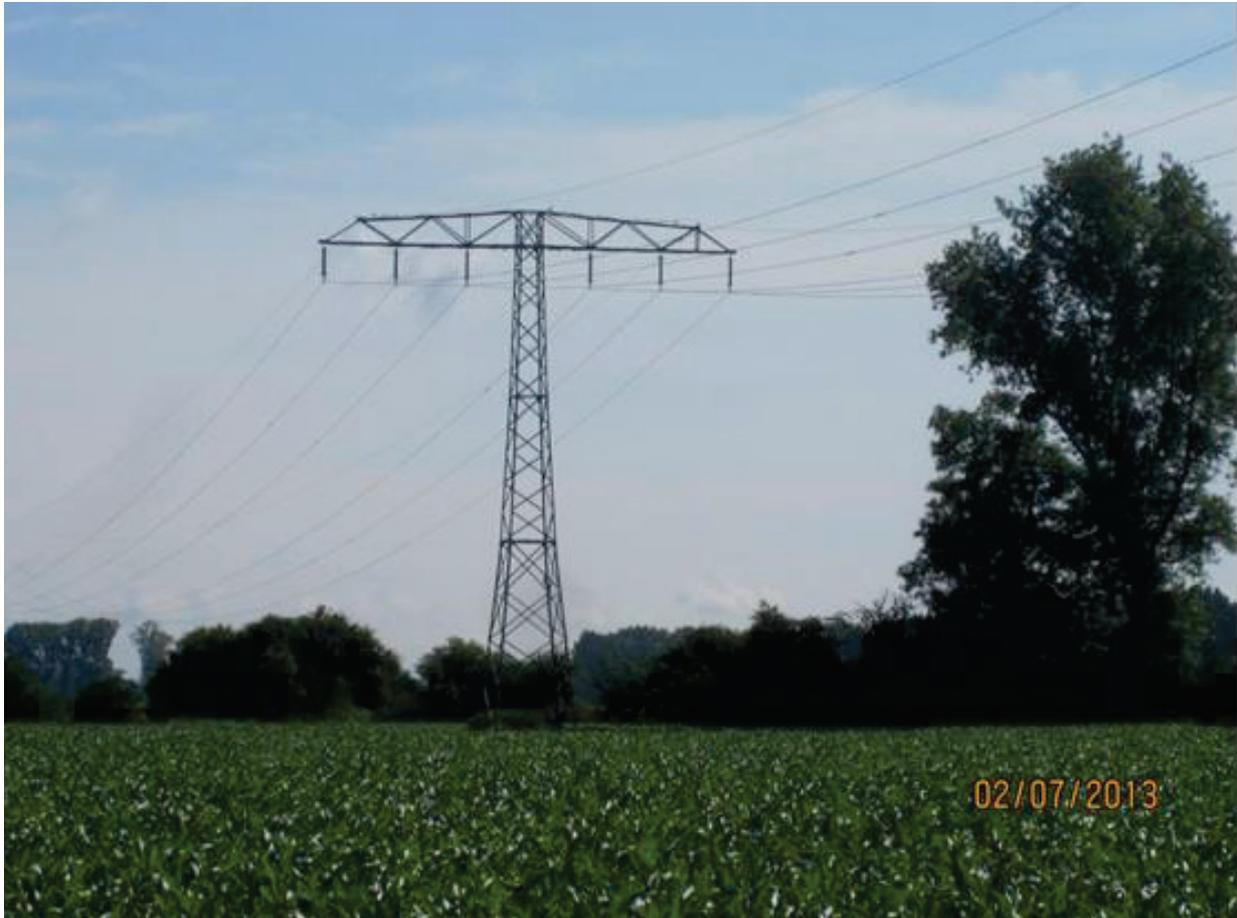
**Abbildung 2: Beseilung eines 110-kV-Einebenenmastes**
