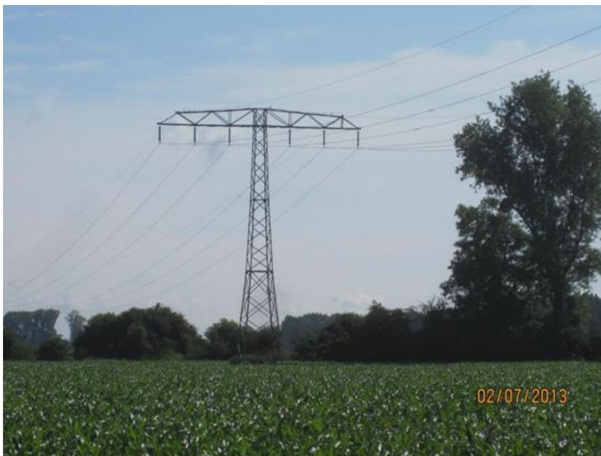
Abbildung 2: Beseilung eines 110-kV-Ebenenmastes
