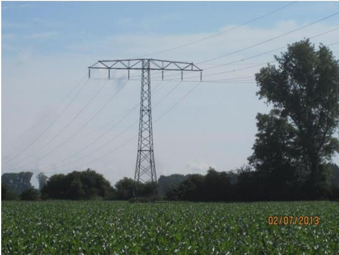
Abbildung 2: Beseilung eines 110-kV-Einebenenmastes
