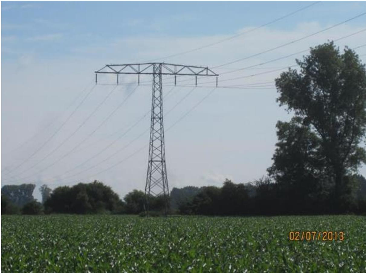
**Abbildung 2: Beseilung eines 110-kV-Einebenenmastes**
