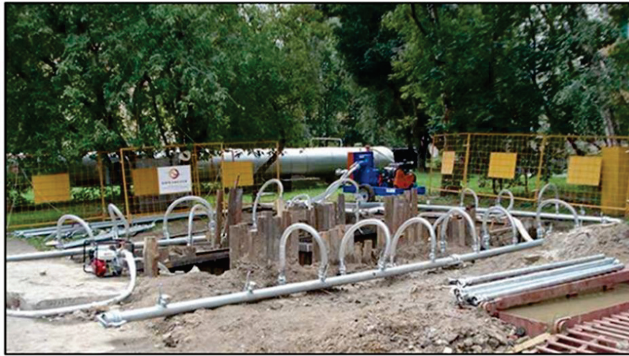
Abb. 1 Praxisbeispiel für geschlossene Wasserhaltung mit Vakuump-Filterlanzen betrieben mit einem Dieselpumpaggregat
