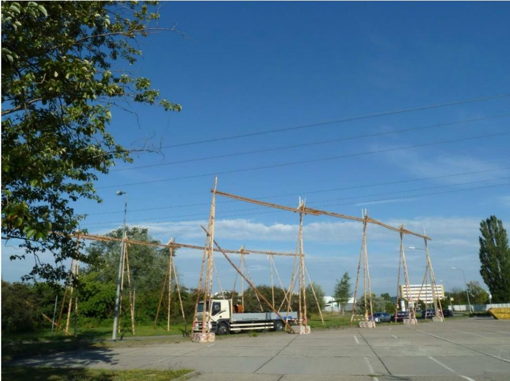
**Abbildung 12: Schleifgerüst (Foto Omexom)**
