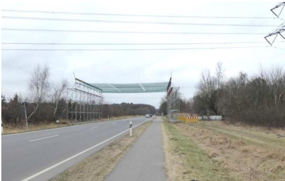
**Abbildung 13: Schutzgerüst (Foto Omexom)**
