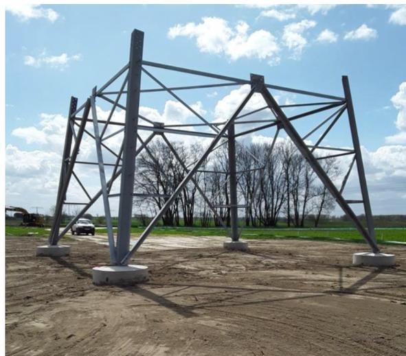
**Abbildung 4: Beispiel eines wiederverfüllten Plattenfundamentes**
