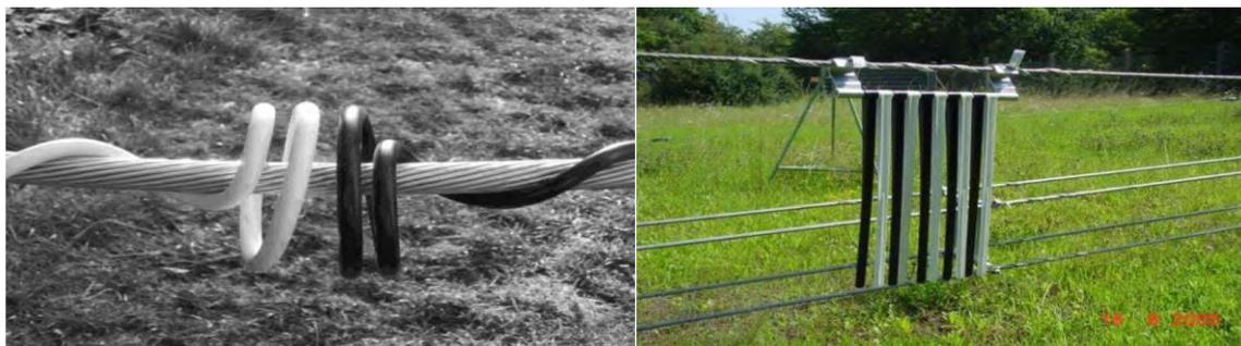
**Abbildung 9: Beispiele für Vogelschutzmarker (links: Spiralmarker, rechts: Klappmarker)**
