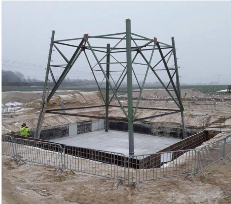
**Abbildung 12: Baugrube mit Fundament (ohne Fundamentköpfe)**
