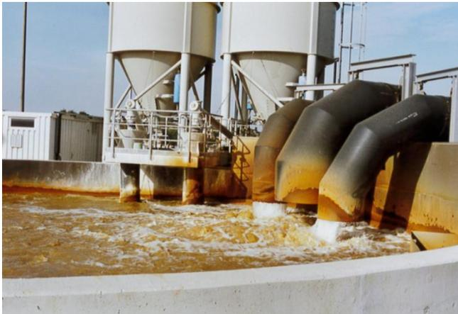
**Bild 12:** Reaktionsbecken der GWRA Rainitza mit den Zuläufen der Rohwässer und den Silos zur Trockendosierung des Flockungsmittels Kalkhydrat.
