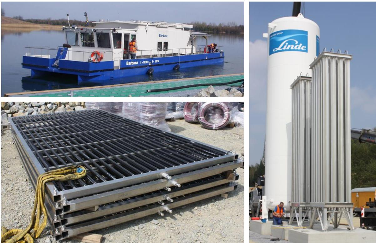
**Bild 11:**  $\text{CO}_2$ -Applikation in Kombination mit einer Inlake-Wasserbehandlung im Lichtenauer See (links oben: Bekalkungsschiff „Barbara“; rechts:  $\text{CO}_2$ -Tank und Verdampfersäulen; links unten: Begasungsrahmen, Fotos: LUG Cottbus).
