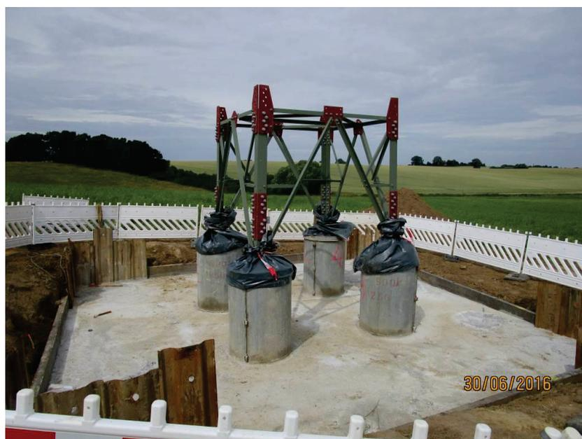
Abb. 21 – Baugrube mit Fundament (Ziel)
