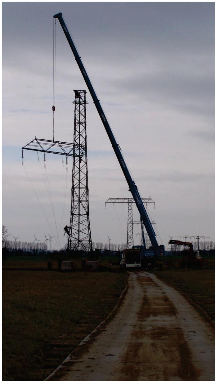
Abb. 22 – Maststellen mittels Autokran (Beispiel)
