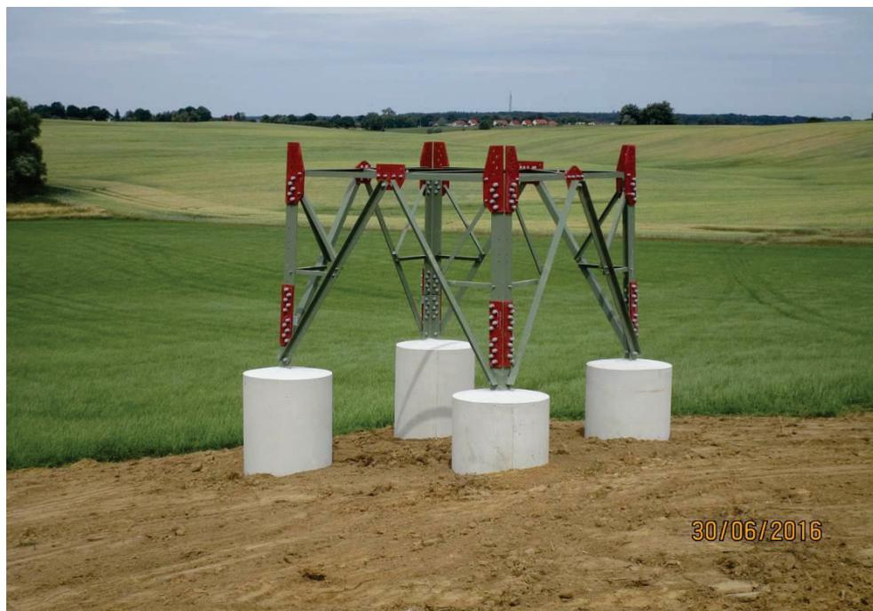
**Abb. 19 – Beispiel eines wiederverfüllten Plattenfundamentes (Beispiel)**
