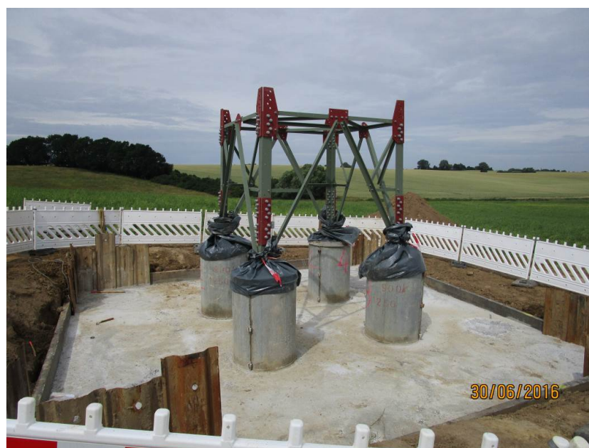
Abb. 21 – Baugrube mit Fundament (Beispiel)
