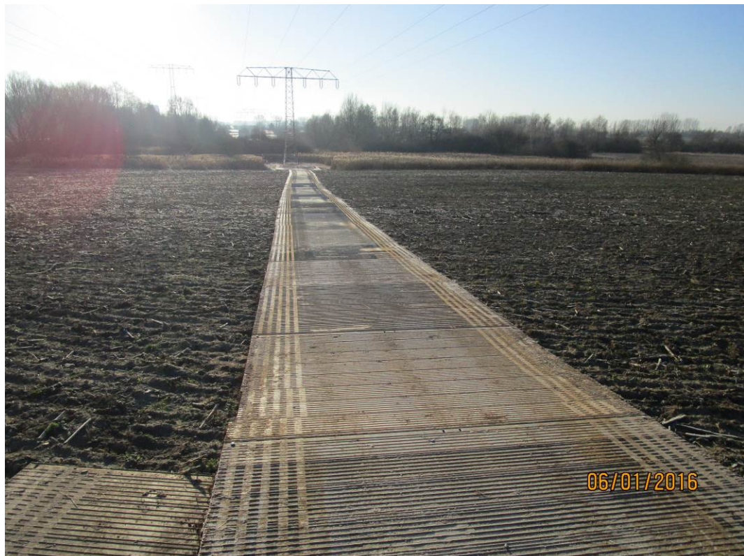
Abb. 20 – Beispiel einer Baustraße mit Matten (Beispiel)
