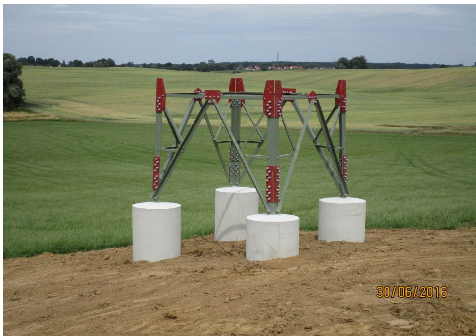
Abb. 19 – Beispiel eines wiederverfüllten Plattenfundamentes (Beispiel)
