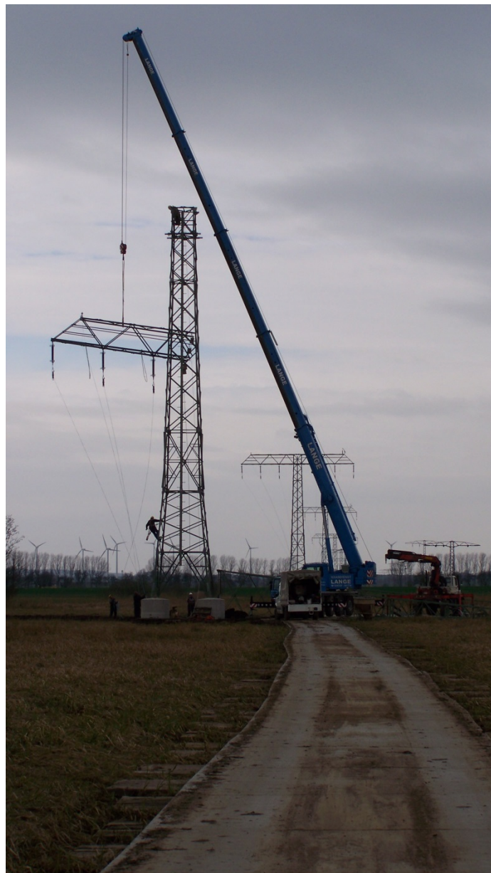
Abb. 22 – Maststellen mittels Autokran (Beispiel)
