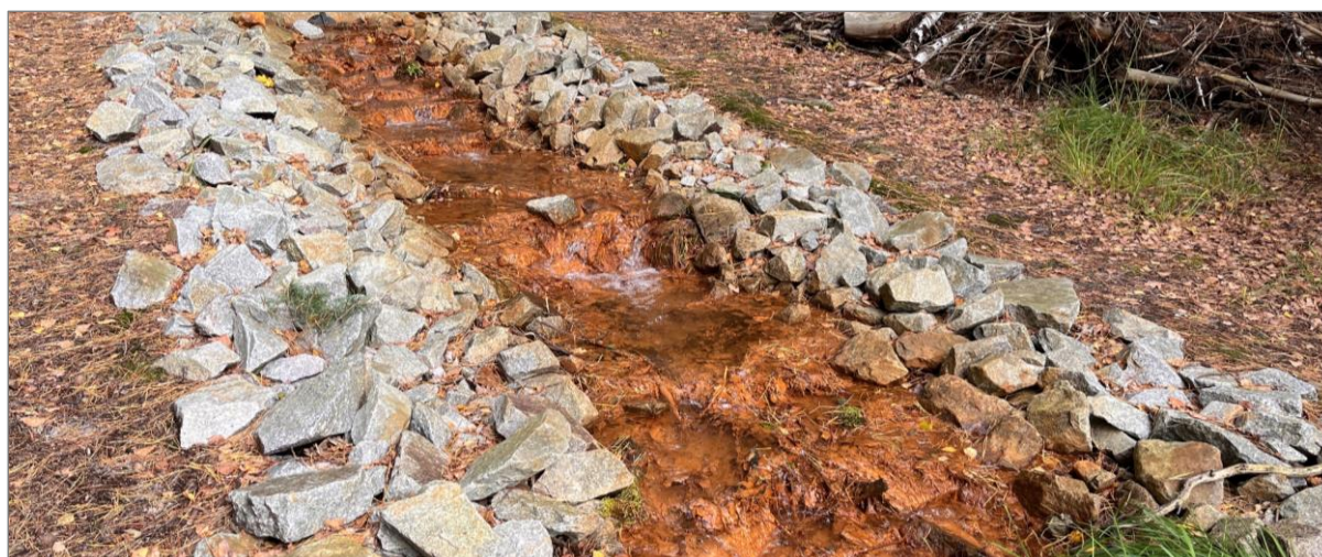
Abbildung 5.19: Kleinsee – Zustand der Einleitkaskade
