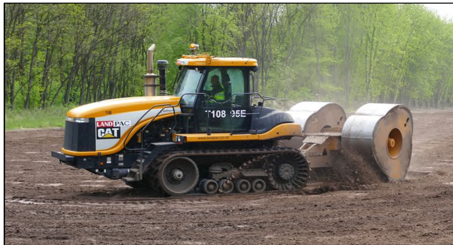
Abbildung 7-2: Oberflächenverdichtung mittels Verfahren der Hochenergetischen Dynamischen Schlagverdichtung (Landpac-Verfahren), Foto Falk Hoffmann
