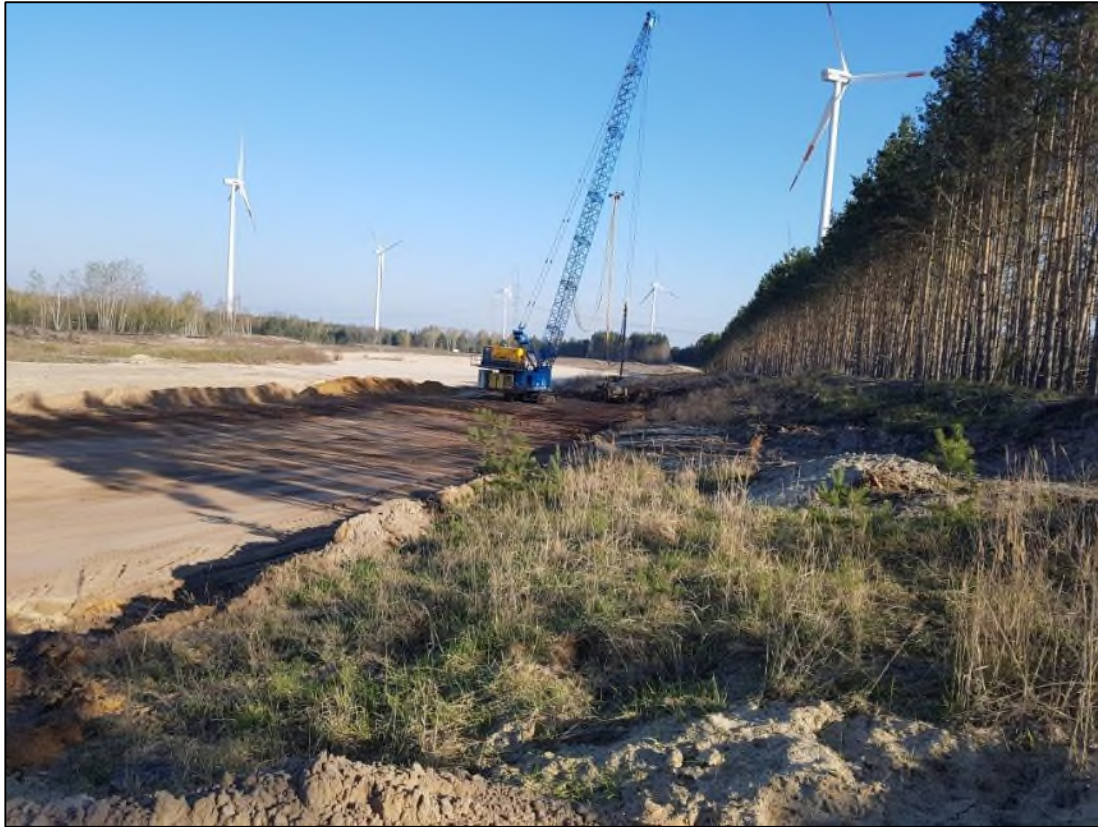
Abbildung 4-1: Rütteldruckverdichtung am Werkstattgraben Süd im ehemaligen Tagebau Greifenhain (Foto Falk Hoffmann, G.U.B. Ingenieur AG, 05/2019)
