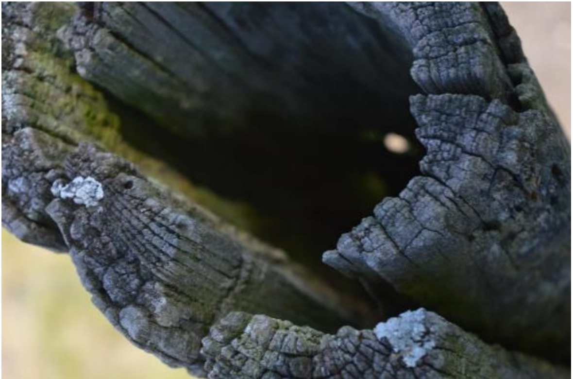
Abbildung 19: Höhlung im Pfahl - Brutplatz des Baumläufers zwischen M99n und 98n, 04.06.20
